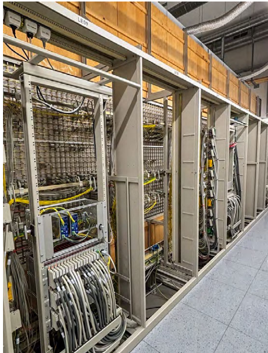
Bild 25: Instrumentierung zur Erfassung digitaler Messwerte in einem Schweizer KKW.
