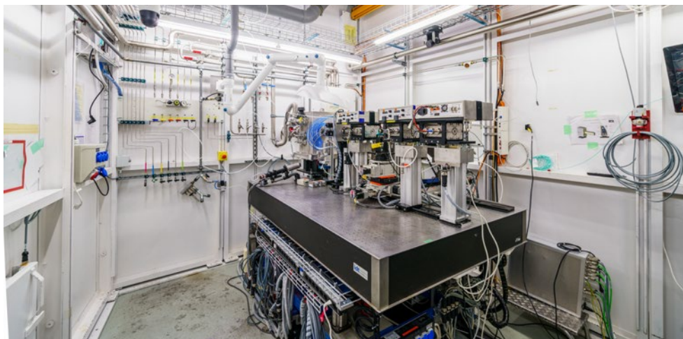
Die Grossforschungsanlage «Synchrotron Lichtquelle Schweiz». Foto: PSI
