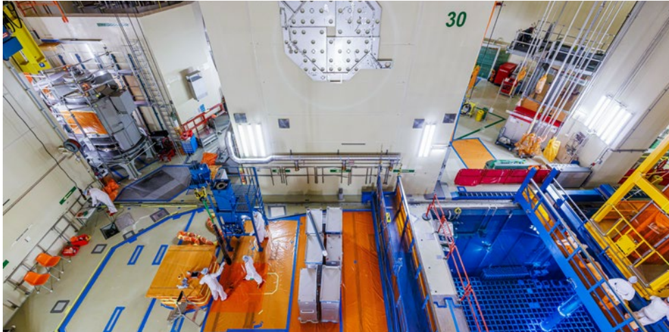
Bolzen des Reaktor- druckbehälters. Foto: KKG
