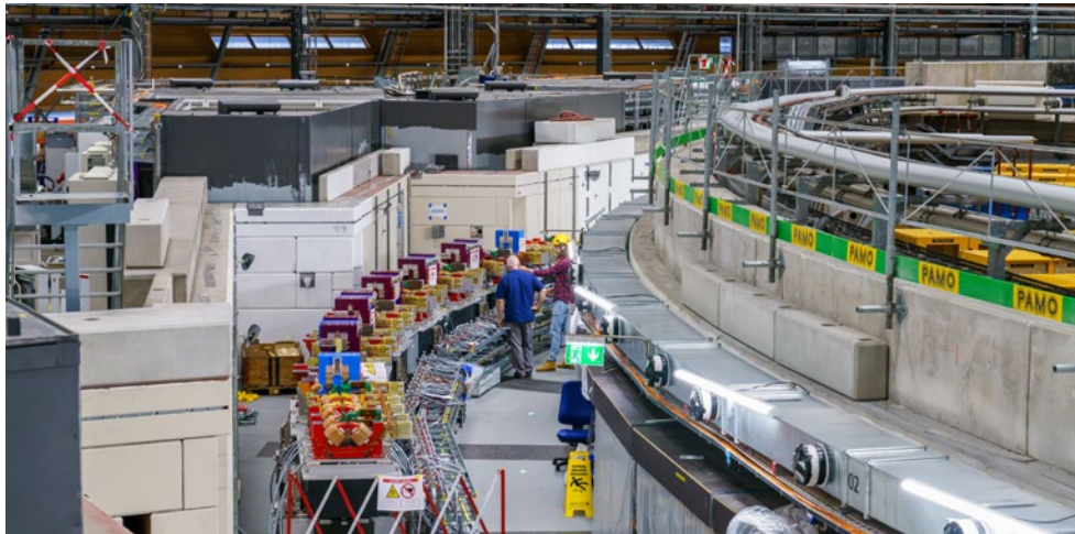
Modernisierung der «Synchrotron Lichtquelle Schweiz». Foto: PSI
