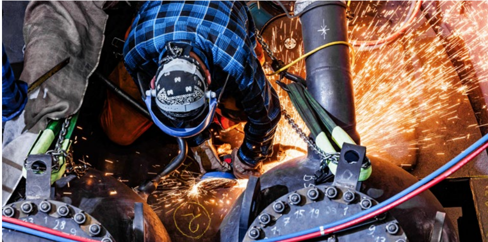
Arbeiten am Wasserabscheider- Zwischenüberhitzer. Foto: KKG
