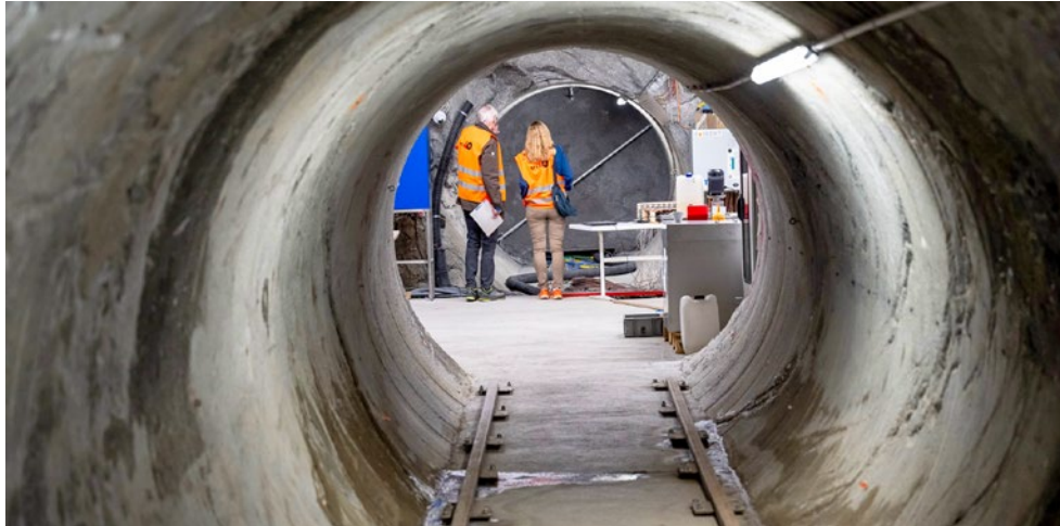
Das Felslabor Mont Terri liegt 300 Meter unter der Erdoberfläche. Foto: Nagra
