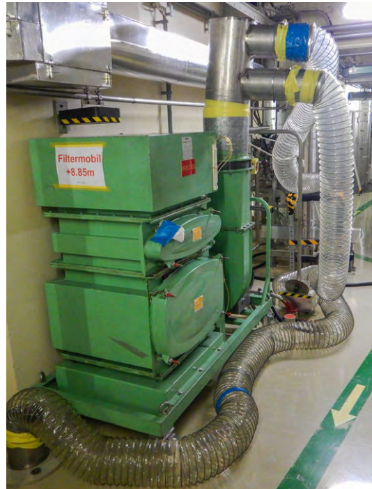
Bild 8: Mit Hilfe dieses Filtermobils wurden die drei Dampferzeuger während des verlängerten Stillstands sekundärseitig konserviert (trocken gehalten).
