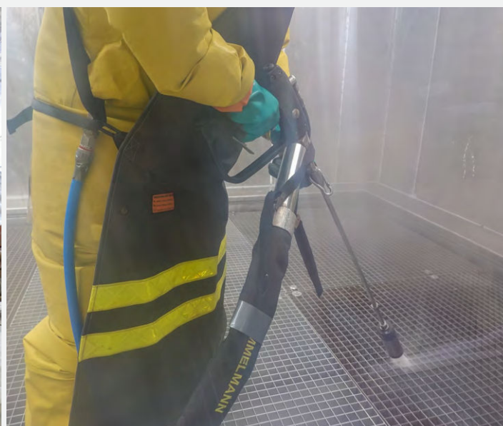
Bild 17: Mit Beton ge- füllter Kühler des «Shut- down and Torus Cooling System» (STCS) (links) und Reinigung kontaminierter Komponenten mittels einer Hochdruck- lanze in der Nassdekonta- minations- anlage im Ma- schinen- haus (rechts).
