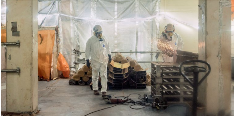
Rückbau- und Zerlegearbeiten in der Kondensation. Foto: BKW
