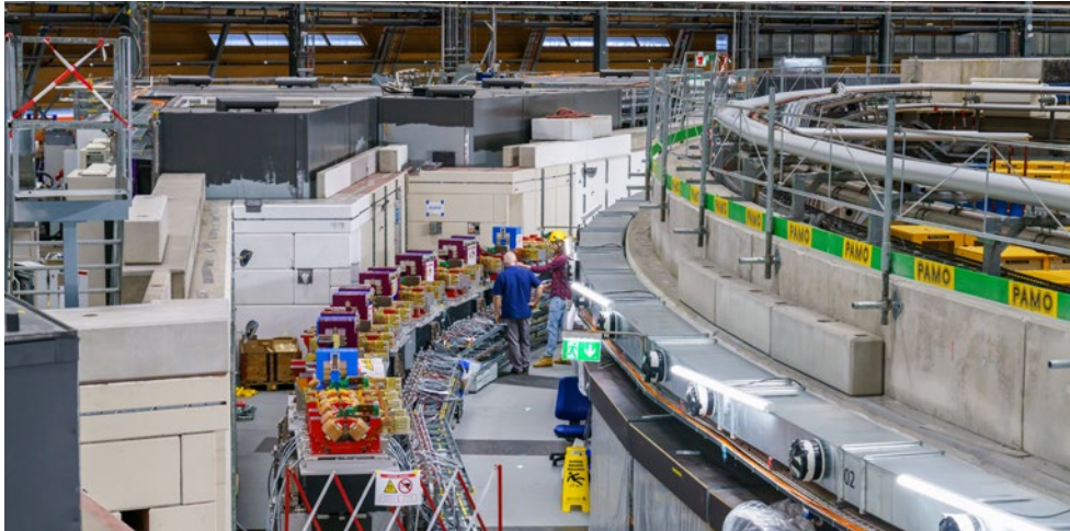
Modernisierung der «Synchrotron Lichtquelle Schweiz». Foto: PSI
