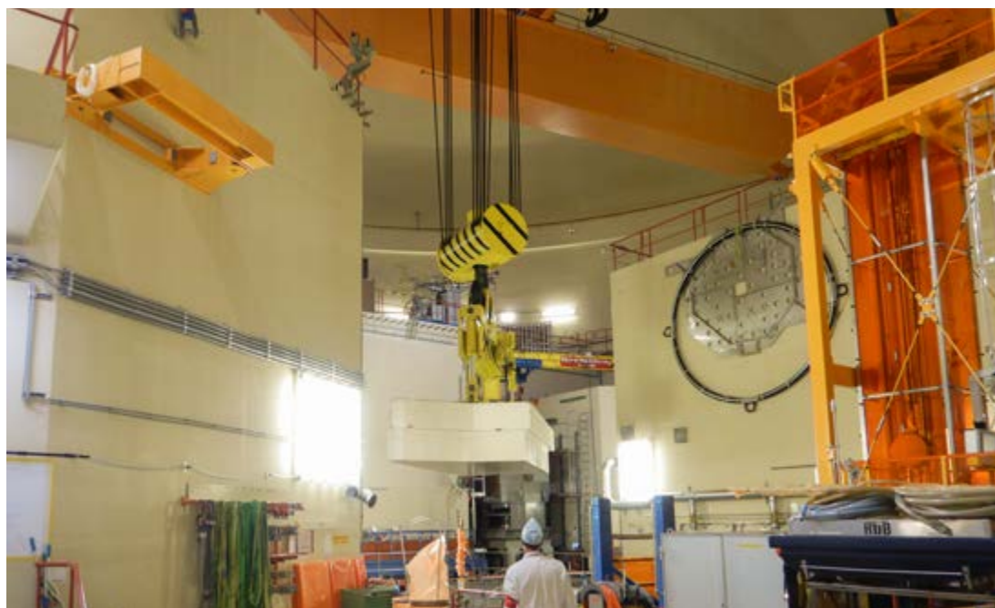
Bild 19: Abheben eines Betonriegels oberhalb des Reaktors.
