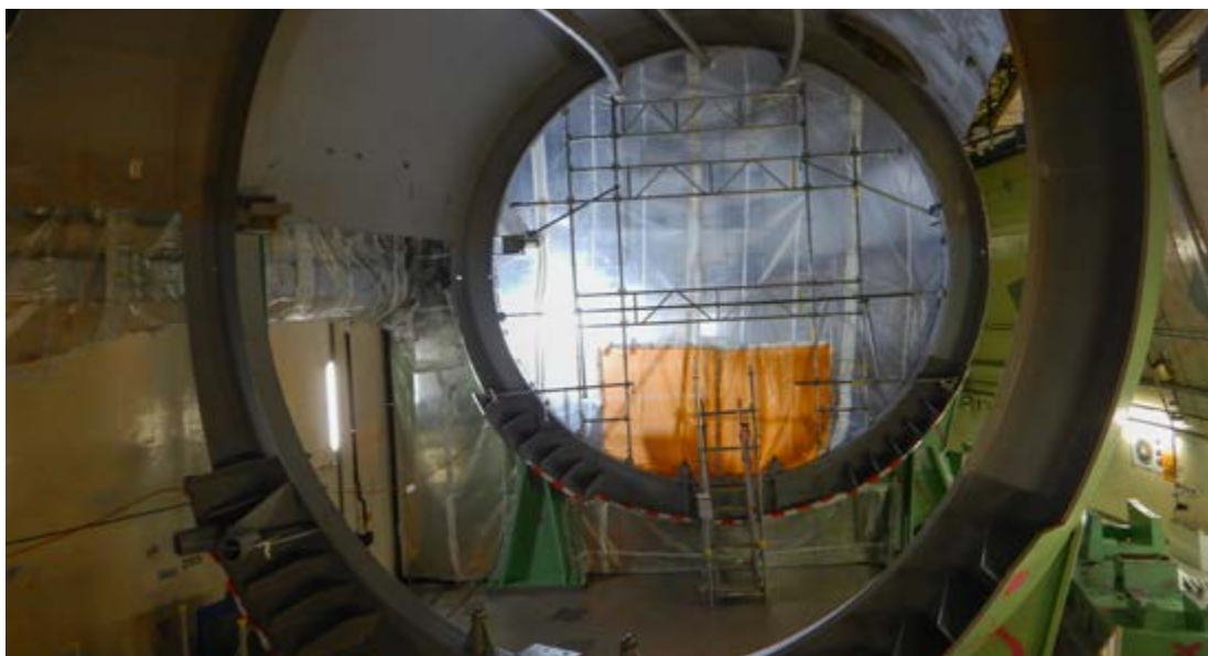
Bild 22: Blick durch den teilzerlegten Torus. Im Hintergrund ist das Gerüst mit Kunststofffolien zu sehen, die den eigentlichen Zerlegebereich unter anderem aus strahlenschutztechnischen Gründen vom umgebenden Raum abtrennen.
