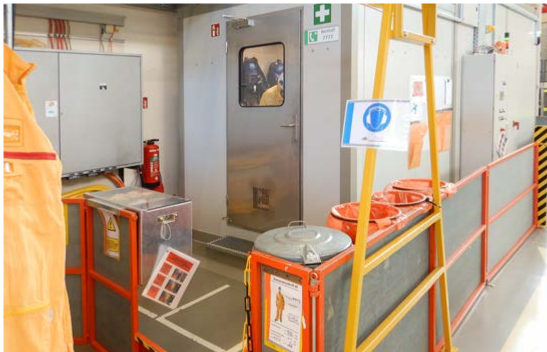
Bild 24: Zugang zum thermischen Zerlegecaisson. In der Schleuse zum eigentlichen Arbeitsbereich zieht ein Mitarbeiter des KKM die erforderliche Schutzausrüstung an.
