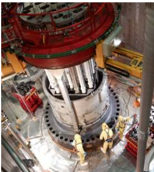
Bild 5: In der Reaktorgrube (Zone-IV) werden mit Schutzanzügen Arbeiten an den RDB-Deckel-Bolzen ausgeführt.
