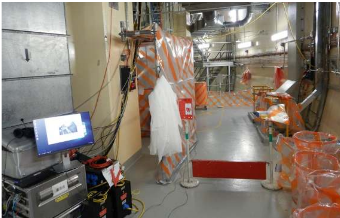
Bild 6: Temporärer Zonenübergang und -bereich für Dampferarbeiten mit der entsprechenden Infrastruktur. Jenseits des roten Zonenbretts ist ein Zonentyp IV eingerichtet, welcher erhöhte Anforderungen an die persönliche Schutzausrüstung bedingt.
