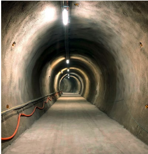
Abbildung 23: Blick in den Rohbau der neuen, fast fertigen Galerie 18. Quelle: S. Schefer, swisstopo
