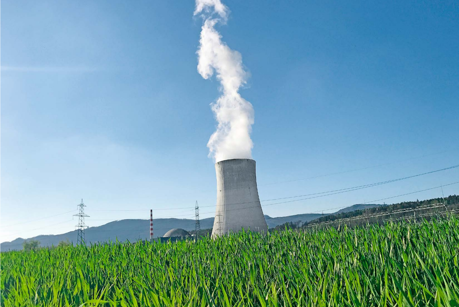
Vue de l'extérieur de la centrale nucléaire de Gösgen (Image : Eveline Strub/ conseil de l'IFSN)
