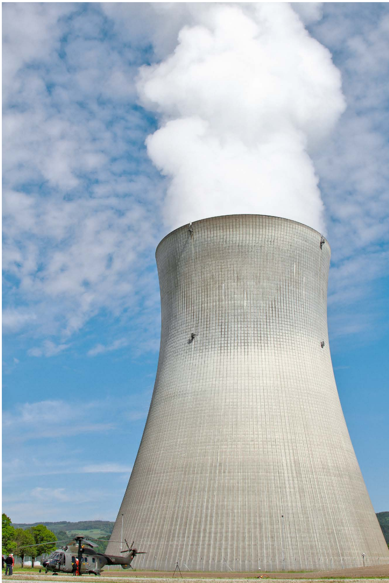
Exercice avec hélicoptère à la centrale nucléaire de Leibstadt (Image : ENSI)
