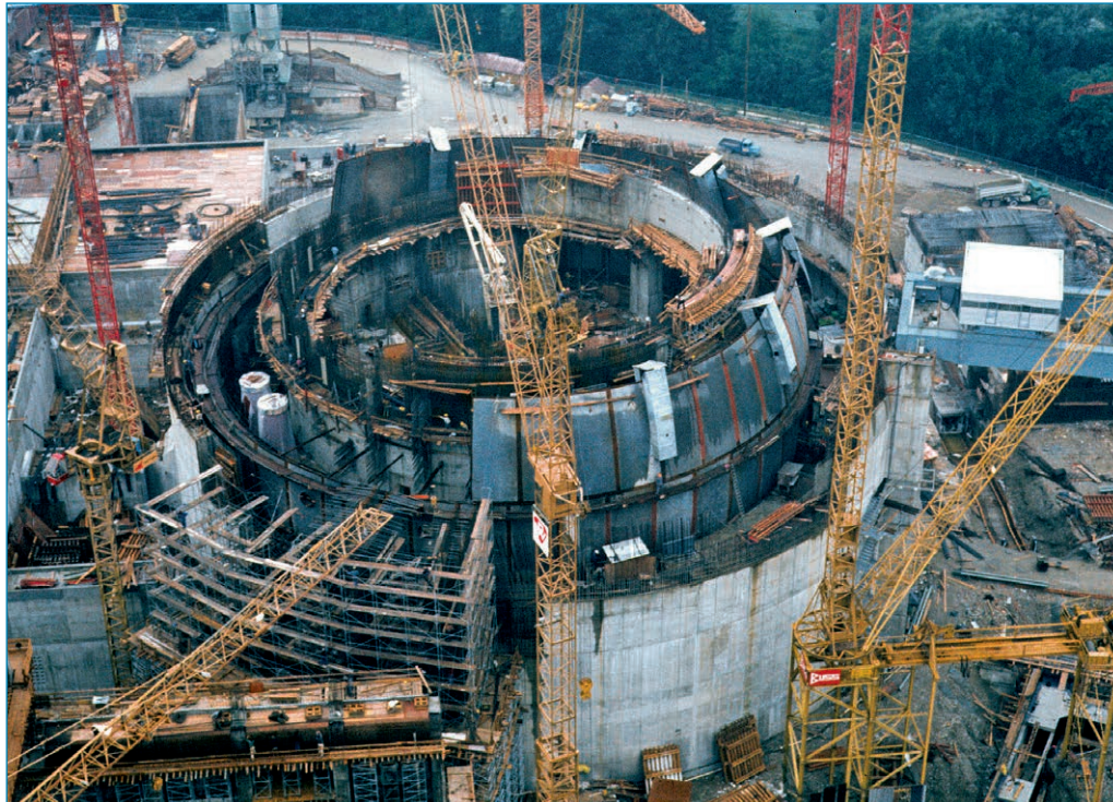
Construction of Gösgen NPP - Source Kernkraftwerk Gösgen-Däniken AG
