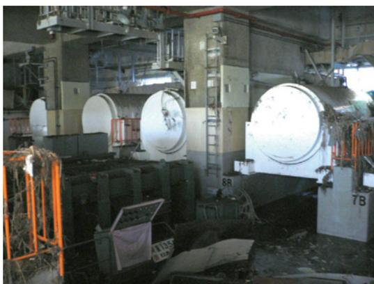
Fig. 2-3 Situation dans le local de stockage à sec de la centrale nucléaire de Fukushima Dai-ichi<sup>7</sup>
