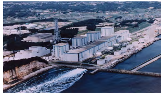
Figure 17: Fukushima Daini, vue d'ensemble Source: TEPCO
