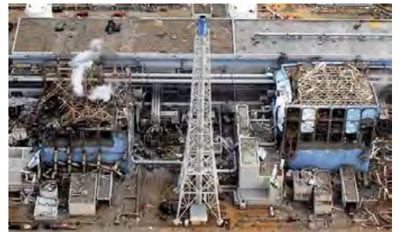
Figure 14: Vue des tranches 3 et 4 après les explosions d'hydrogène Source: TEPCO
