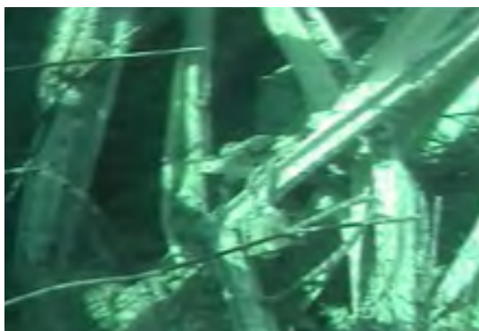
Figure 13: Décombres ayant chuté dans le bassin de stockage de la tranche 3 Source: 18
