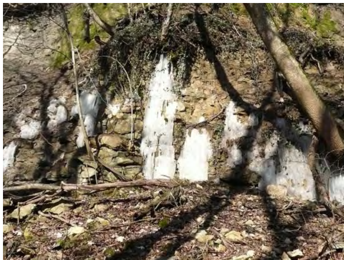
Abb. 2.26: Eisbildungen bei Wasseraustritten aus den Kalken/Sandkalken im Aufschluss Bernhardholz bei Kadelburg. Die Eisbildungen beschränken sich auf den unteren Teil der Wand. Das austretende Wasser versickert im Hangschutt und tritt tiefer am Hang in kleinen Quellen aus. Die Sandkalkbänke werden von mergeligen Formationen des mittleren Doggers überlagert. (Aufnahme Januar 2011, CH-Koord.: 665'730/273'700)
