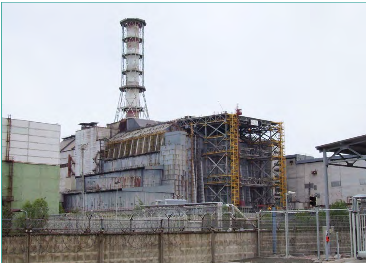
Figur 5: Blick auf den zerstörten Block 4 des Kernkraftwerks Tschernobyl.
