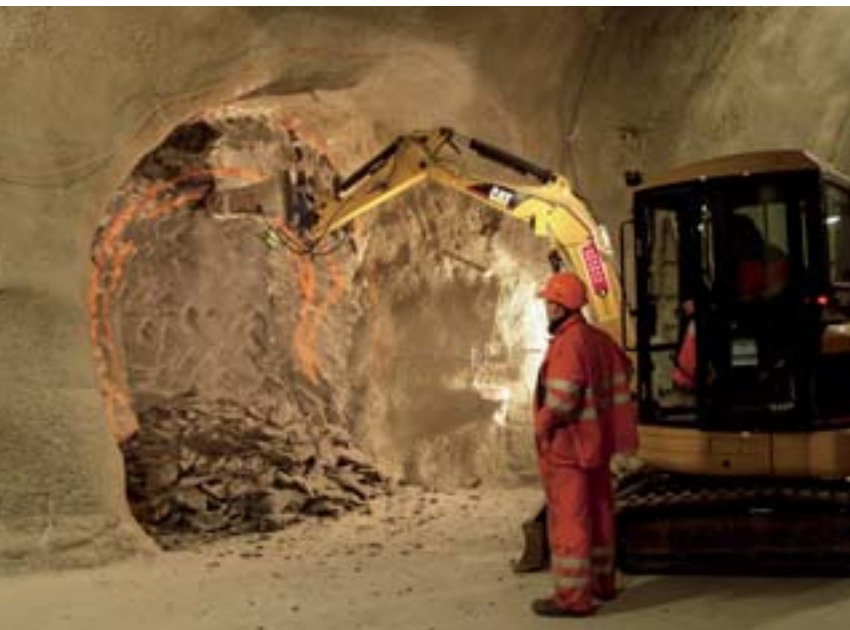
Beginn der Ausbrucharbeiten für einen Teststollen im Felslabor Mont-Terri.
