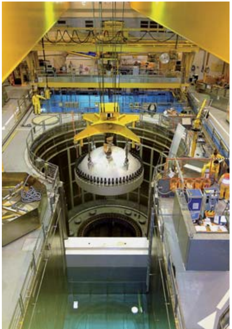
Jahresrevision: Öffnung des Reaktordruckbehälters. Foto: KKM
