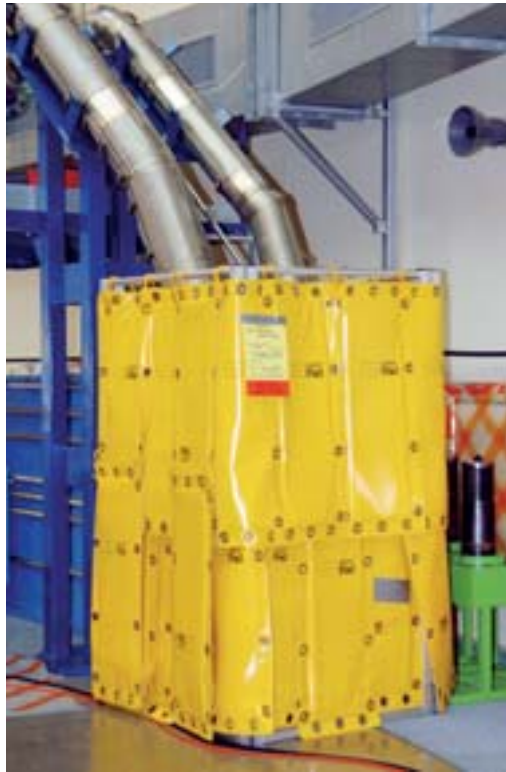
Bleimatten schützen die Mitarbeiter bei der Revision vor radioaktiver Bestrahlung. Foto: KKL
