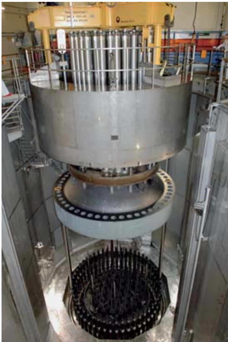
Nach Abschluss der Revisionsarbeiten wird der Reaktordeckel montiert.
