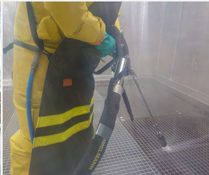
Bild 17: Mit Beton gefüllter Kühler des «Shut-down and Torus Cooling System» (STCS) (links) und Reinigung kontaminierter Komponenten mittels einer Hochdrucklanze in der Nassdekontaminationsanlage im Maschinenhaus (rechts).
