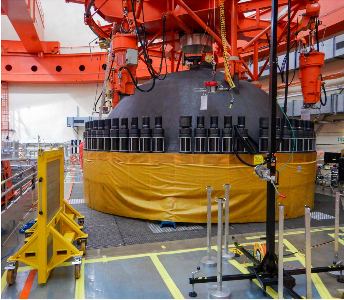
Bild 10: Demontage des Reaktor- druckbe- hälter-Deckels während des Revisionsstill- stands.
