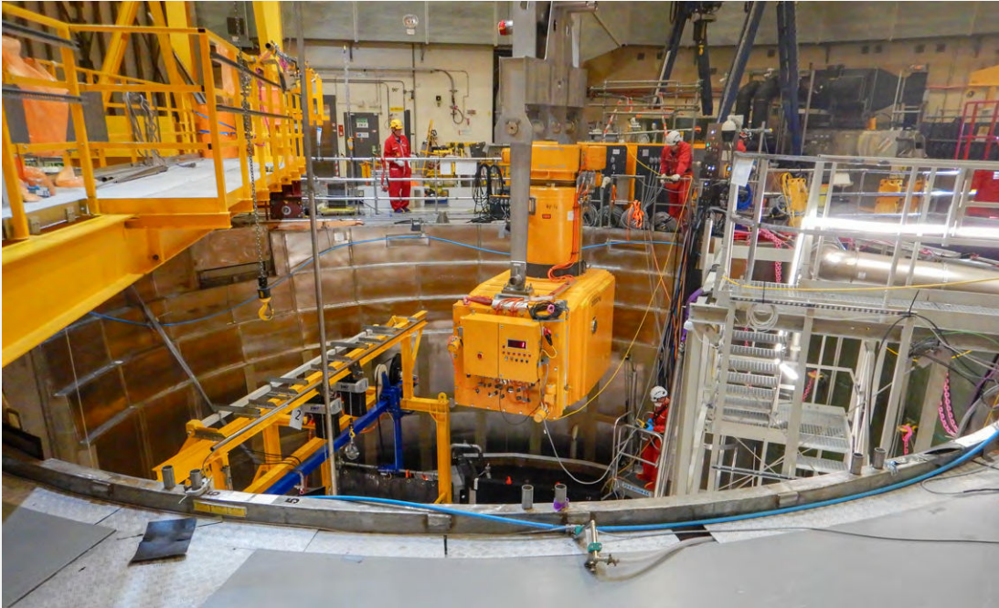
Bild 15: Hilfseinrichtungen in der Reaktorgrube für die Zerlegung der Kerneinbauten im Reaktor-druckbehälter.
