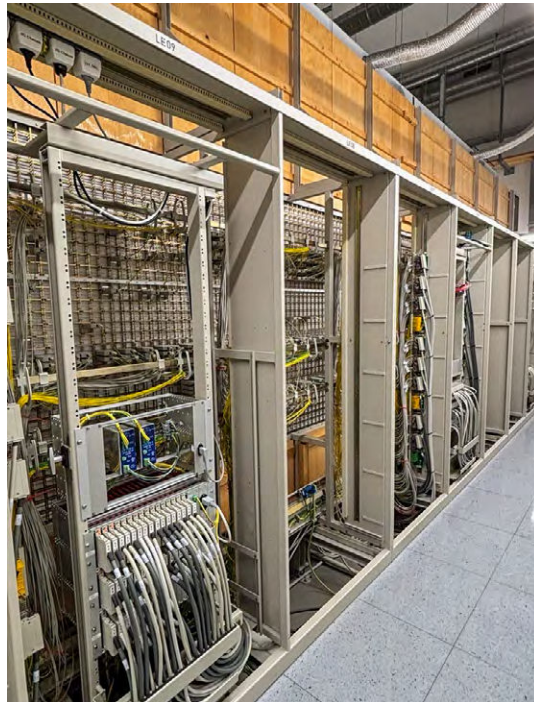
Bild 25: Instrumentierung zur Erfassung digitaler Messwerte in einem Schweizer KKW.
