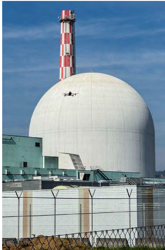
Bild 24: Eine vom Anlagenbetreiber eingesetzte Drohne überfliegt das Gelände des Kernkraftwerks Leibstadt.
