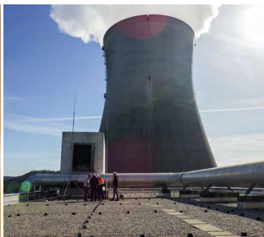
Bild 12 Links: Prüfung der ODL an einer Zonengrenze durch einen ENSI-Inspektor. Rechts: Messung der Ortsdosisleistung auf dem Dach eines KKL-Betriebsgebäudes.
