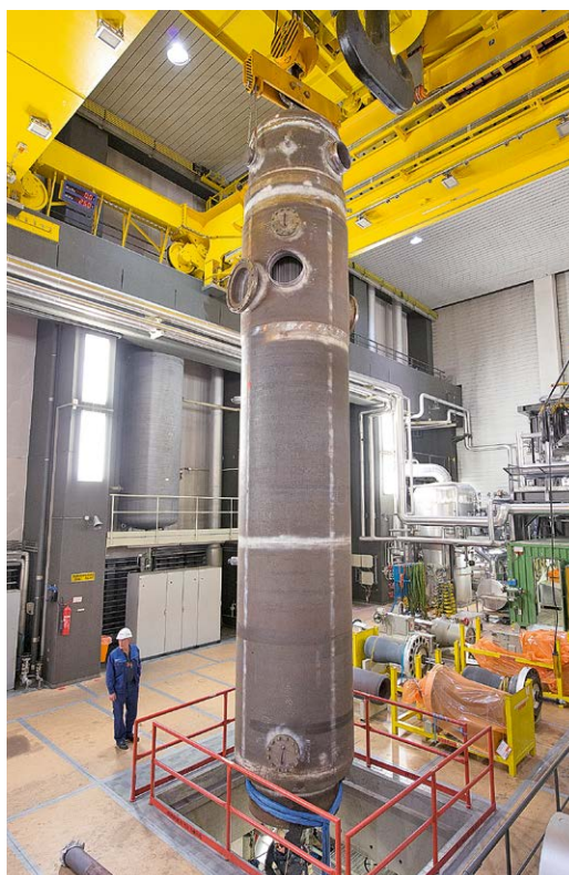
Einbau eines Niederdruck-Vorwärmers. Foto: KKG
