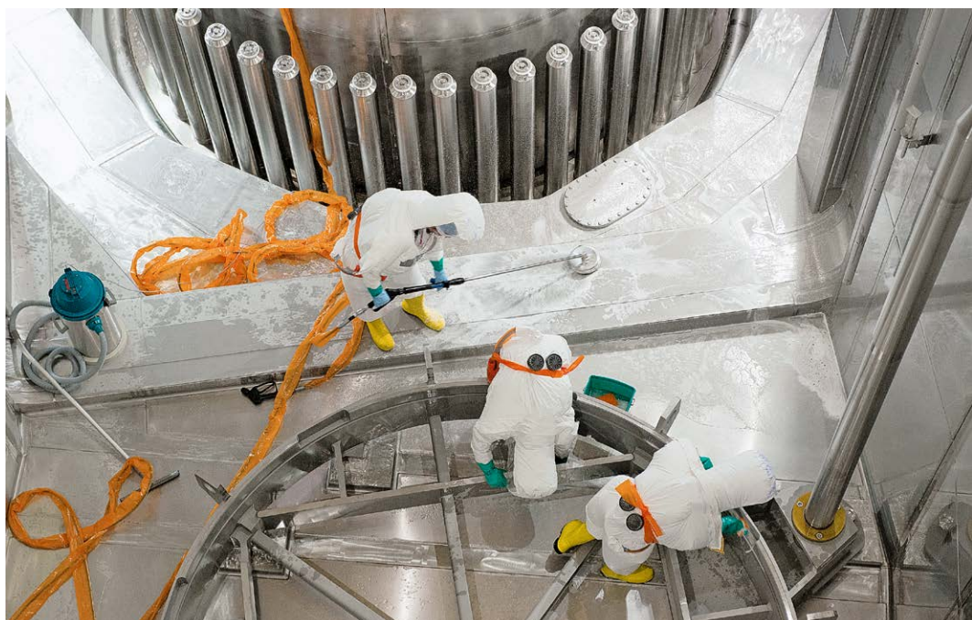
Reinigung der Reaktorgube. Foto: KKG
