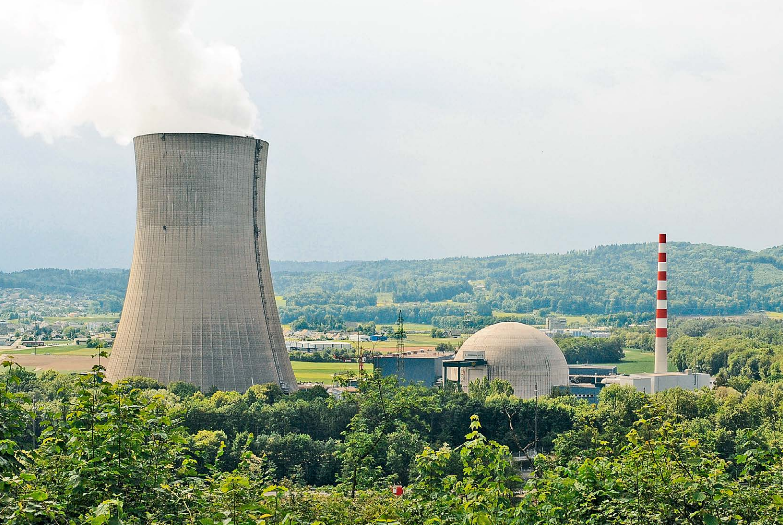
Kernkraftwerk Gösgen. Foto: KKG
