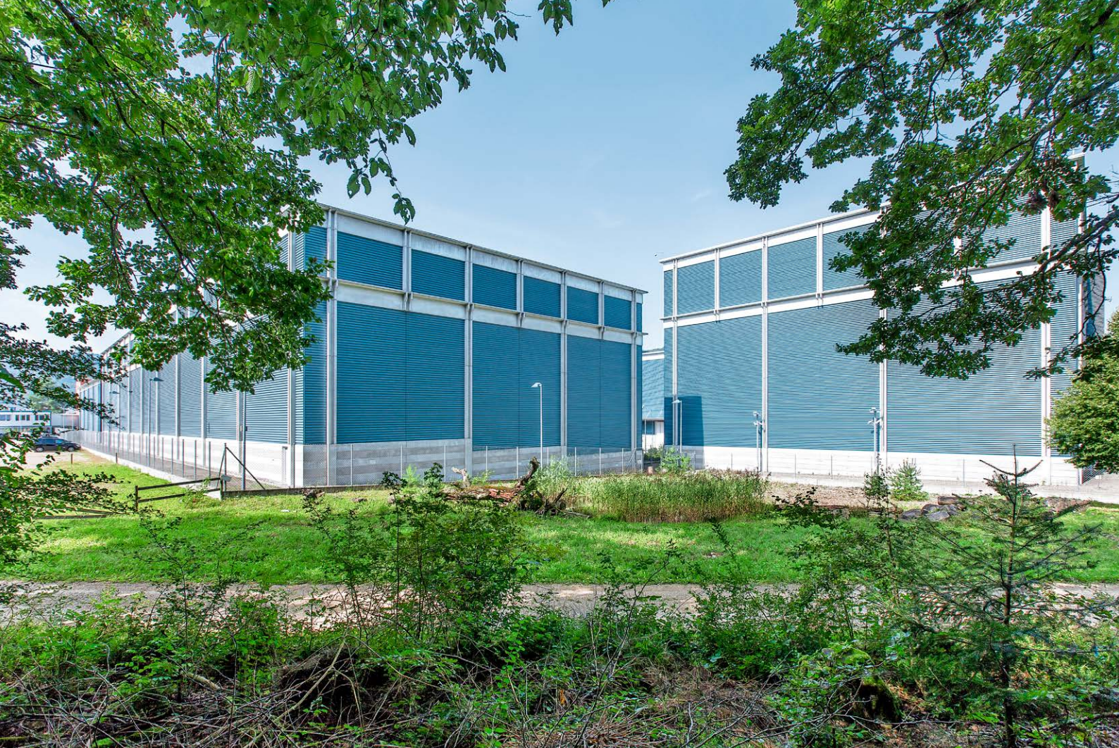
Zentrales Zwischenlager Würenlingen. Foto: Zwiilag
