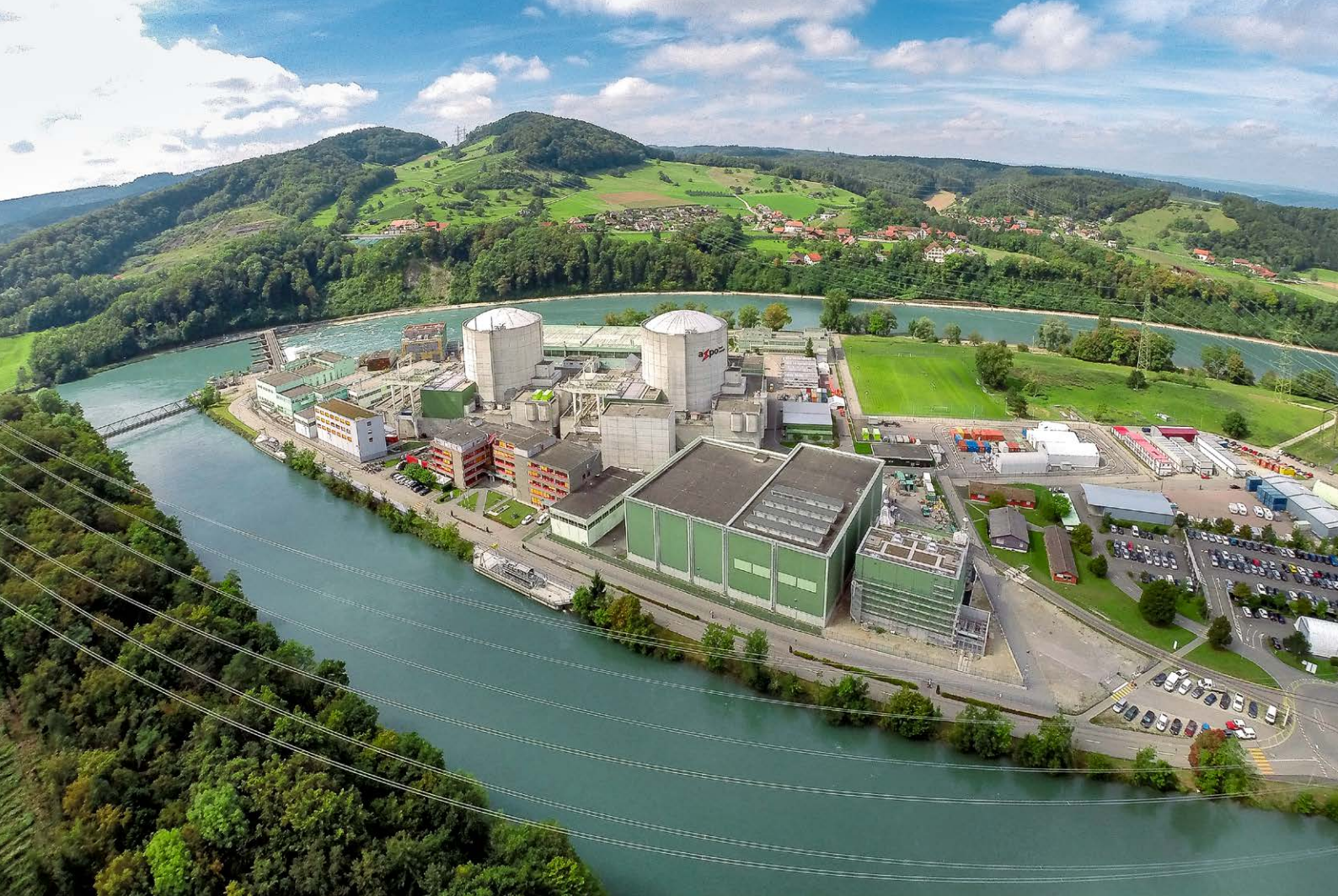
Kernkraftwerk Beznau. Foto: KKB
