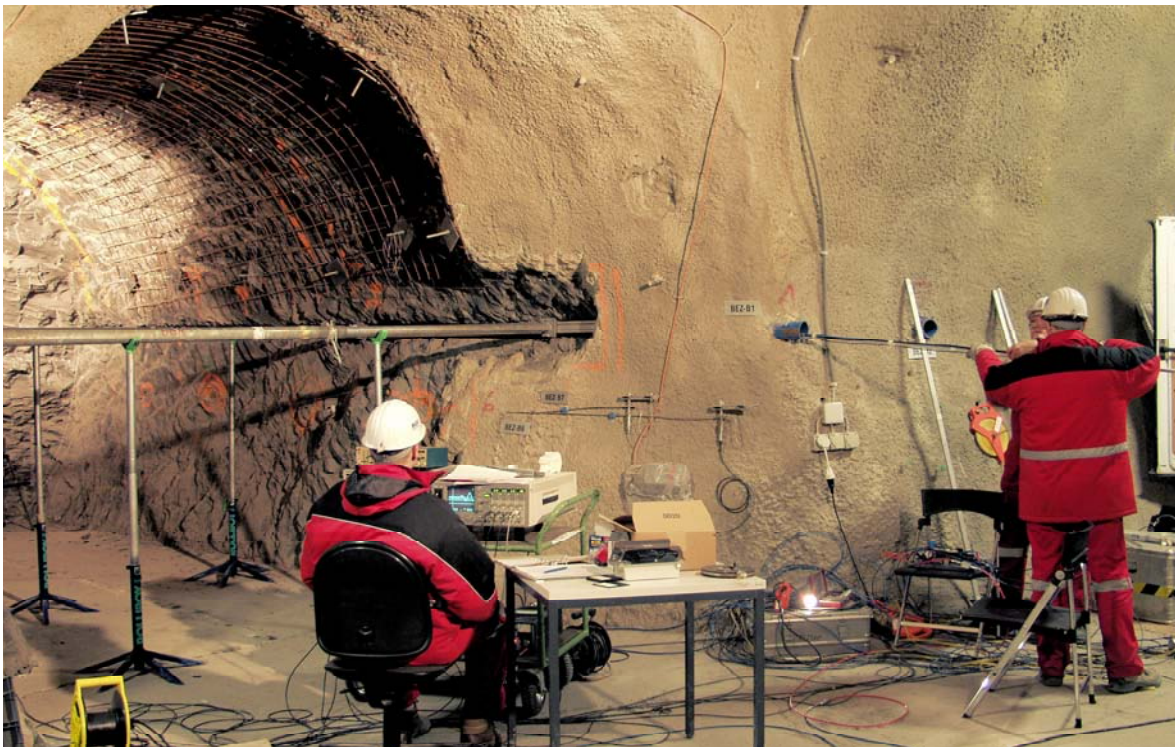
Blick in den Teststollen des EZ-B Experimentes (Länge 6.5 m, Durchmesser 3. 8m). Ausführung geophysikalischer Messungen zur seismischen Charakterisierung der Auflockerungszone. Quelle: HSK
