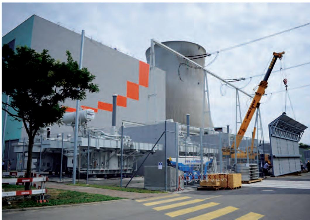
Arbeiten am Blocktransformator: setzen einer Lärmschutzwand (Kranarbeiten).
