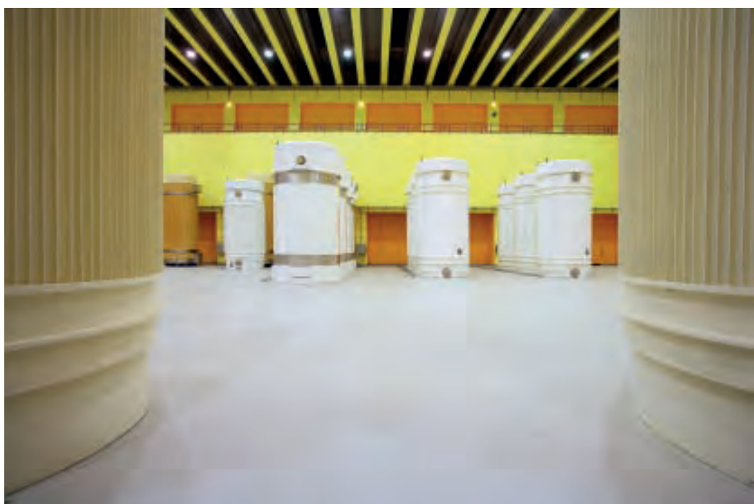
Blick in die Lagerhalle für verglaste, hoch radioaktive Abfälle und für verbrauchte Brennelemente, die in bis zu 135 Tonnen schweren Stahlbehältern sicher eingeschlossen zwischenlagert werden
