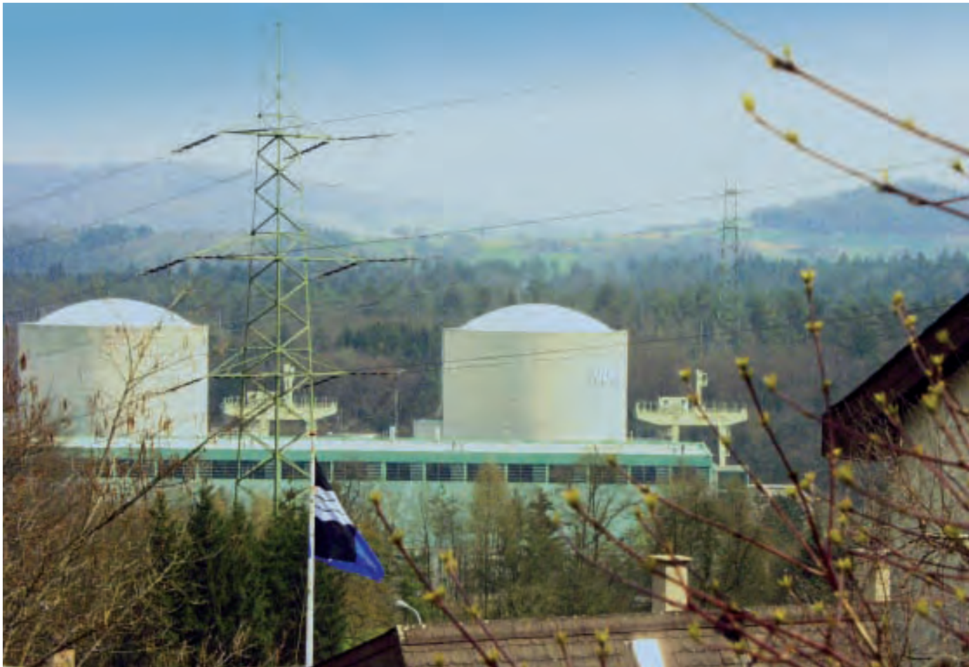
Die beiden Reaktorgebäude des KKW Beznau Foto: KKB
