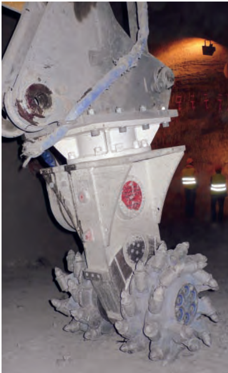
Erweiterung eines Stollens im Felslabor Mont Terri Foto: HSK
