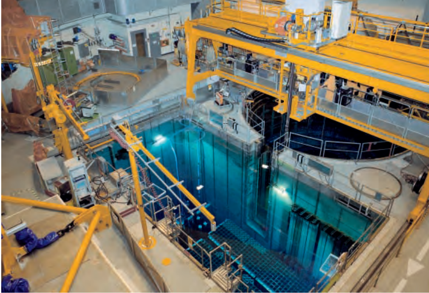
Brennelementwechsel im Kernkraftwerk Mühleberg Foto: KKM
