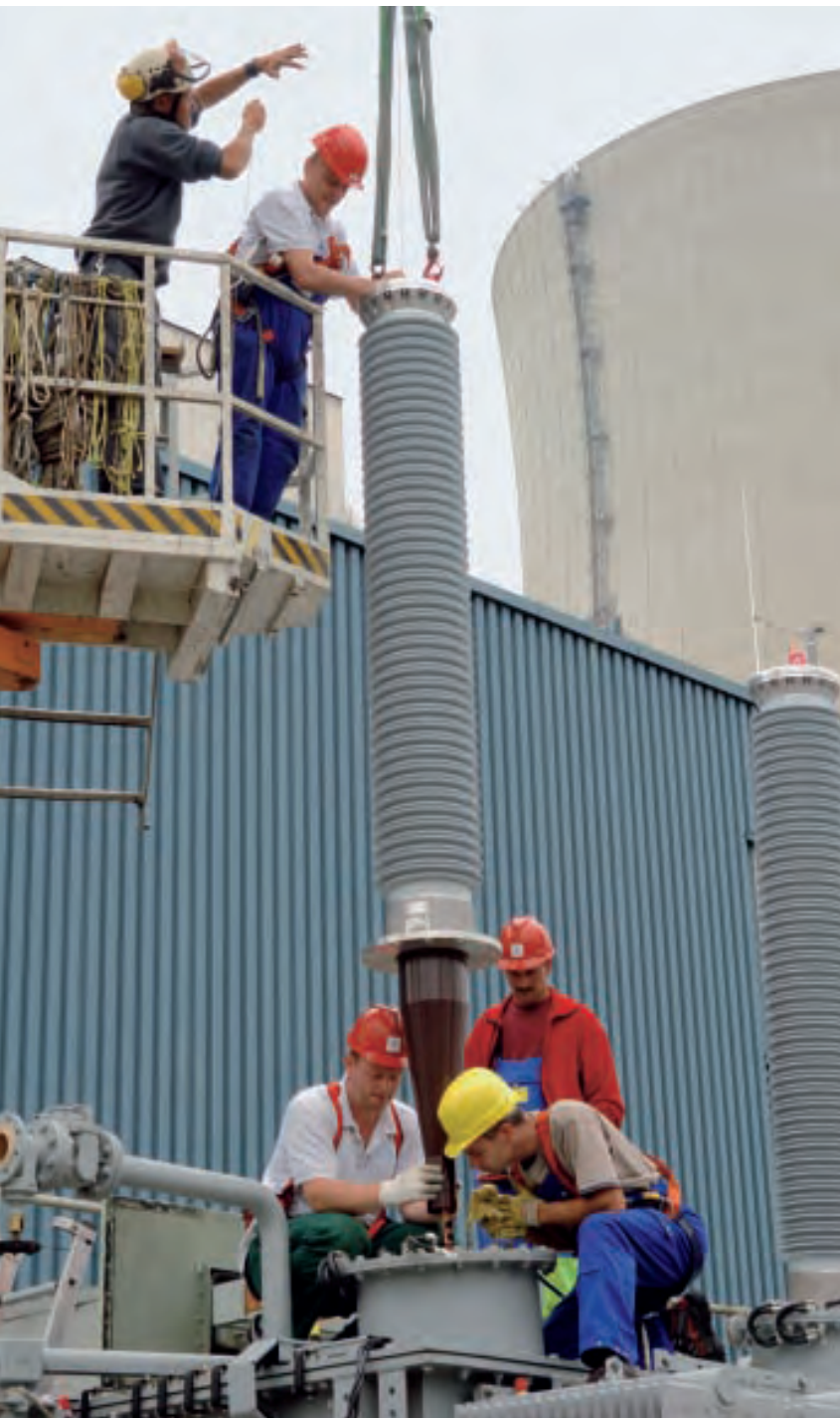
Arbeiten an einem Transformator Foto: KKG
