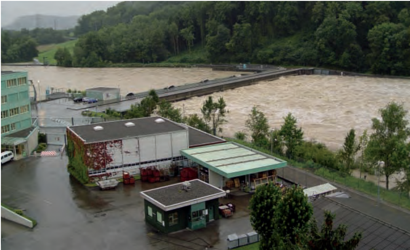
Hochwasser führende Aare beim KKW Beznau am 9. August 2007 Foto: KKB
