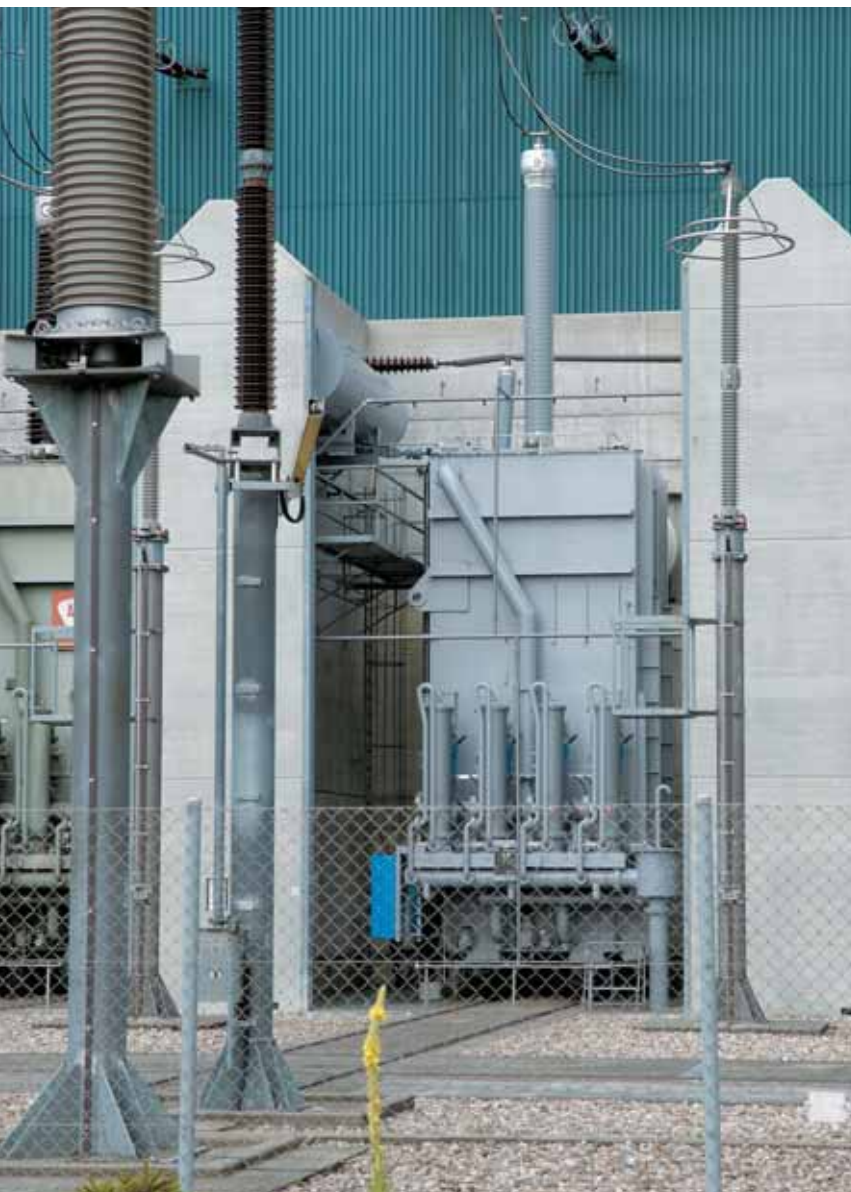
Der revidierte Blocktransformator steht wieder an seinem Platz. Foto: KKG
