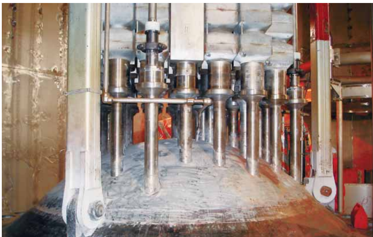
«Deckeldurchführungen» an einem der beiden Reaktordruckbehälter.
