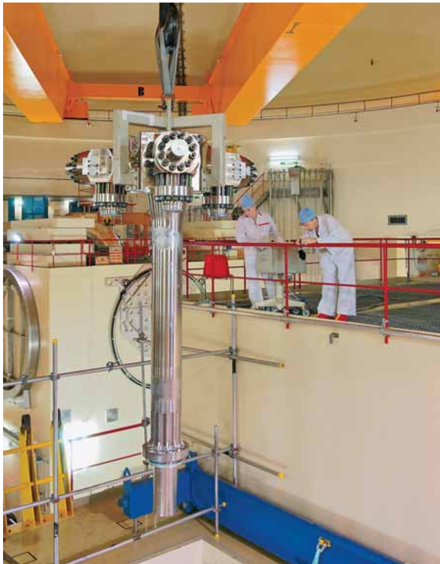
Der neue Druckhalterdom mit den angeflanschten Sicherheitsventilen wird an seinen Platz gehievt.
