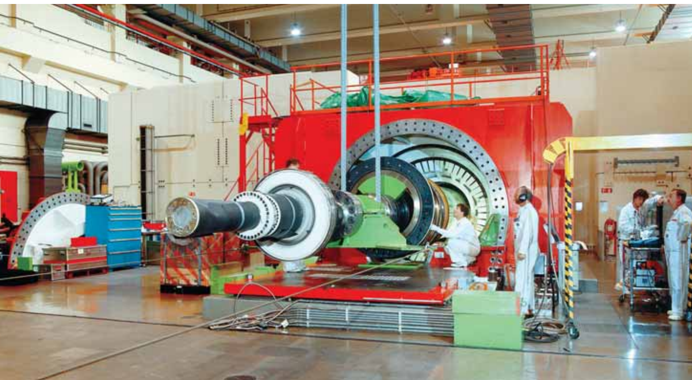
Reparatur-Arbeiten am Generator: Der Rotor wird aus dem Stator ausgefahren. Foto: KKL
