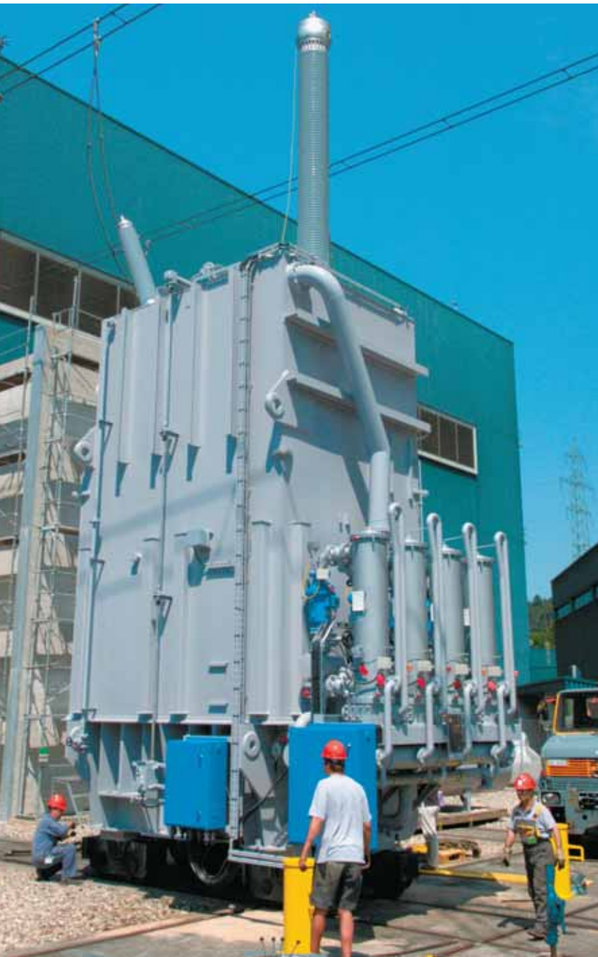
Der revidierte Blocktransformator wird an seinen Platz geschoben.
