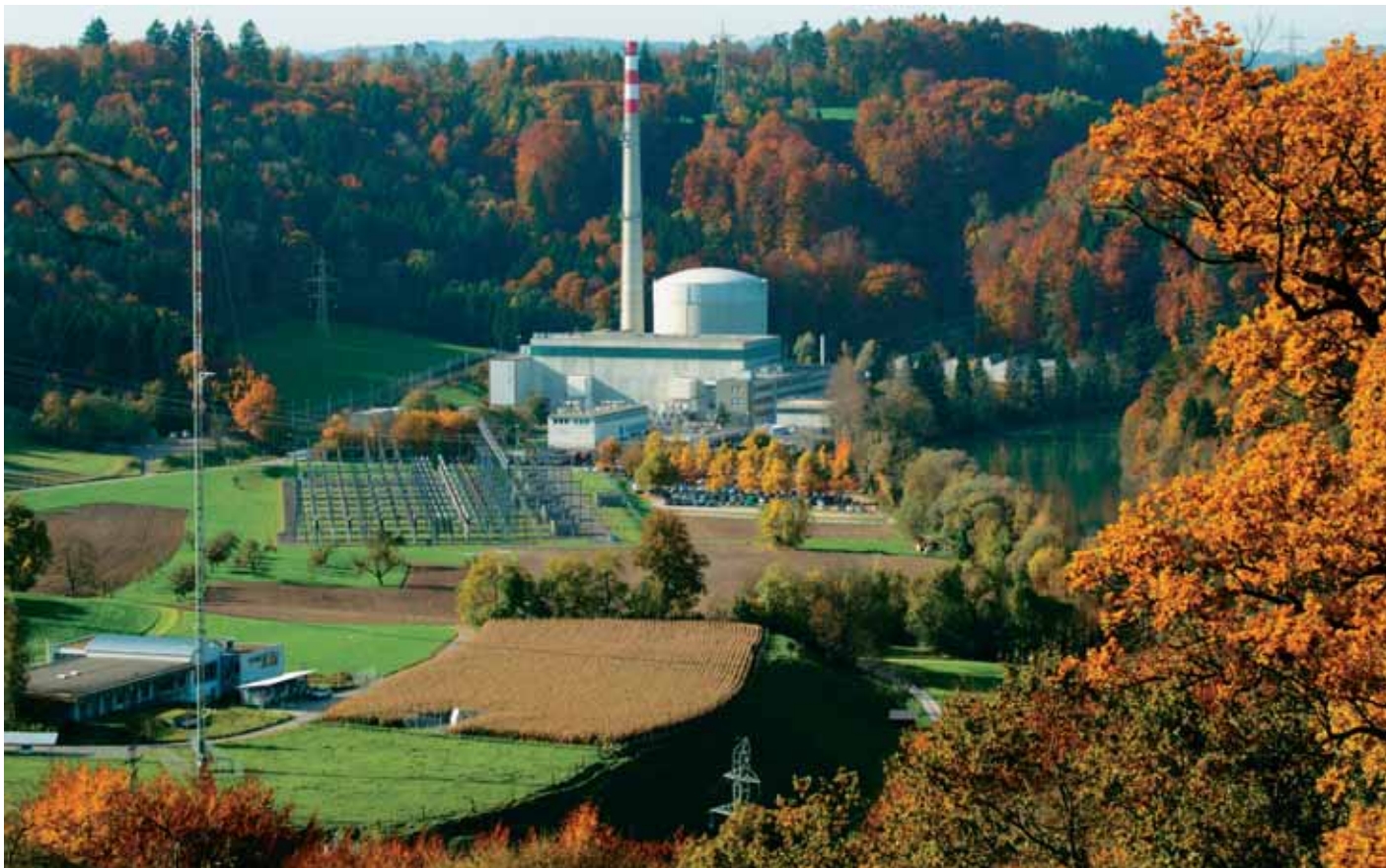
Gesamtansicht des Kernkraftwerks Mühleberg. Foto: KKM
