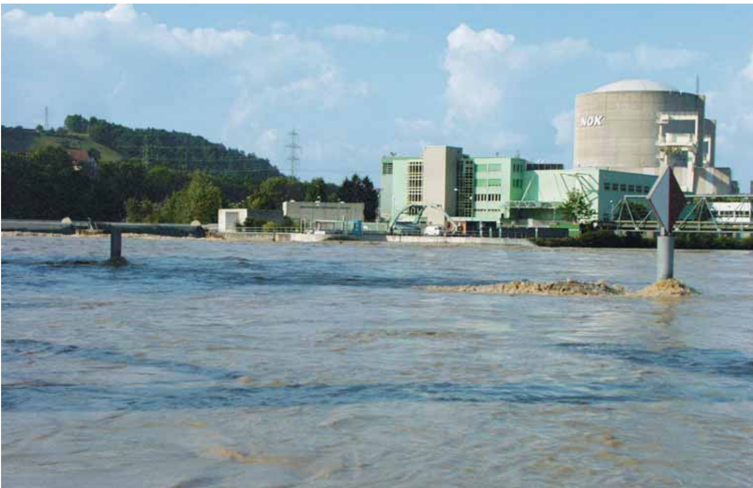
Im August 2005 führte die Aare Hochwasser. Foto: KKB
