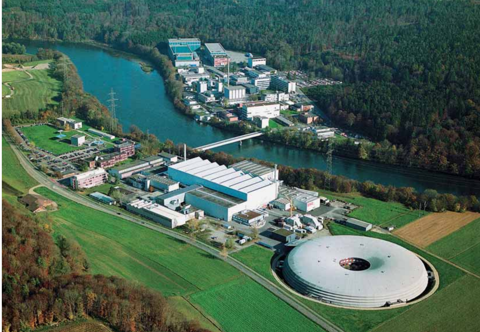
Die Aare trennt das Areal des PSI in den West- (Vordergrund) und den Ost-Teil. Im Hintergrund ist das Zentrale Zwischenlager der ZWILAG erkennbar. Foto: PSI
