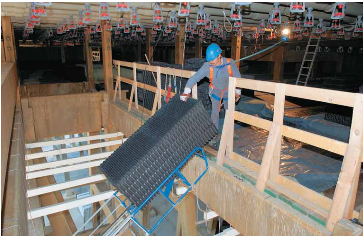
Neue Kühlelemente werden in den Kühlturm von Gösgen eingebaut. Foto: KKG
