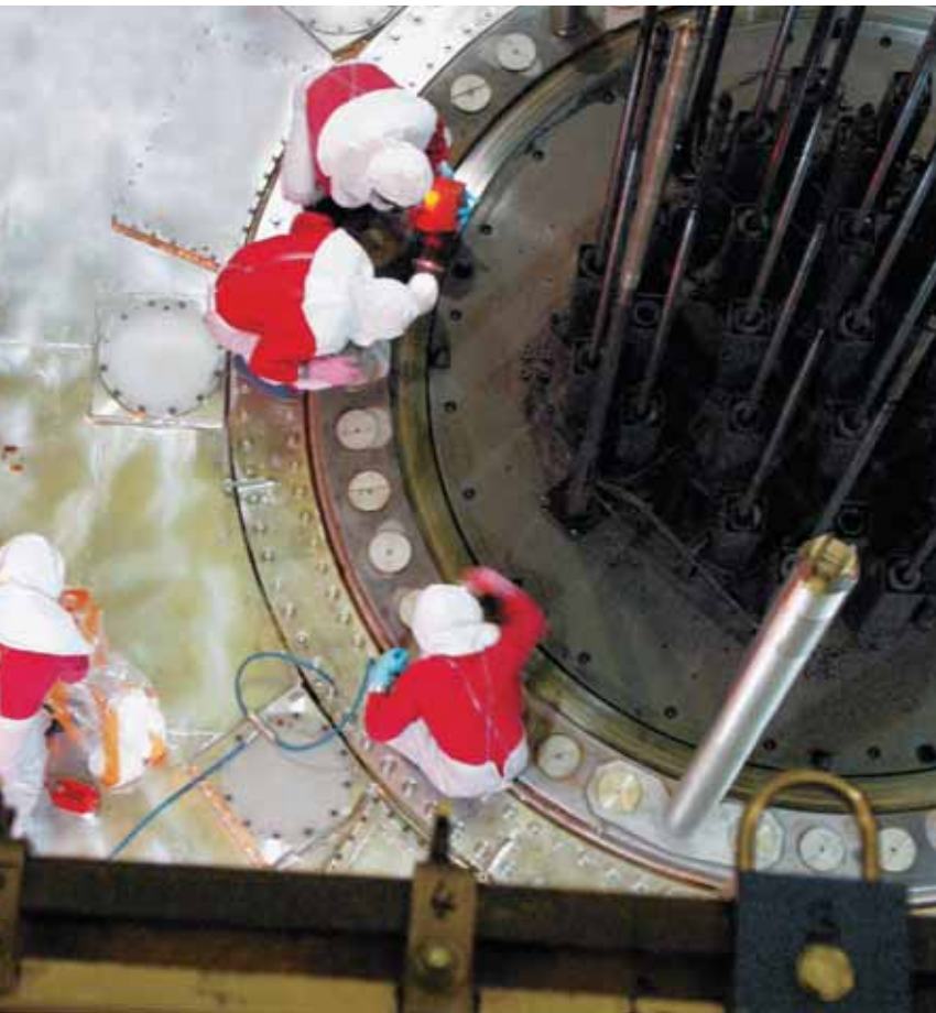
Reinigungsarbeiten am oberen Rand des Reaktordruckbehälters.
