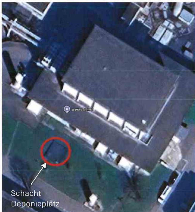
Abbildung 3: Gebäude ODRA mit Schacht
