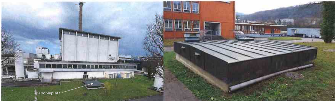
Abbildung 7: Deponieplatz an der Süd-Südwestseite des Gebäudes ODRA
