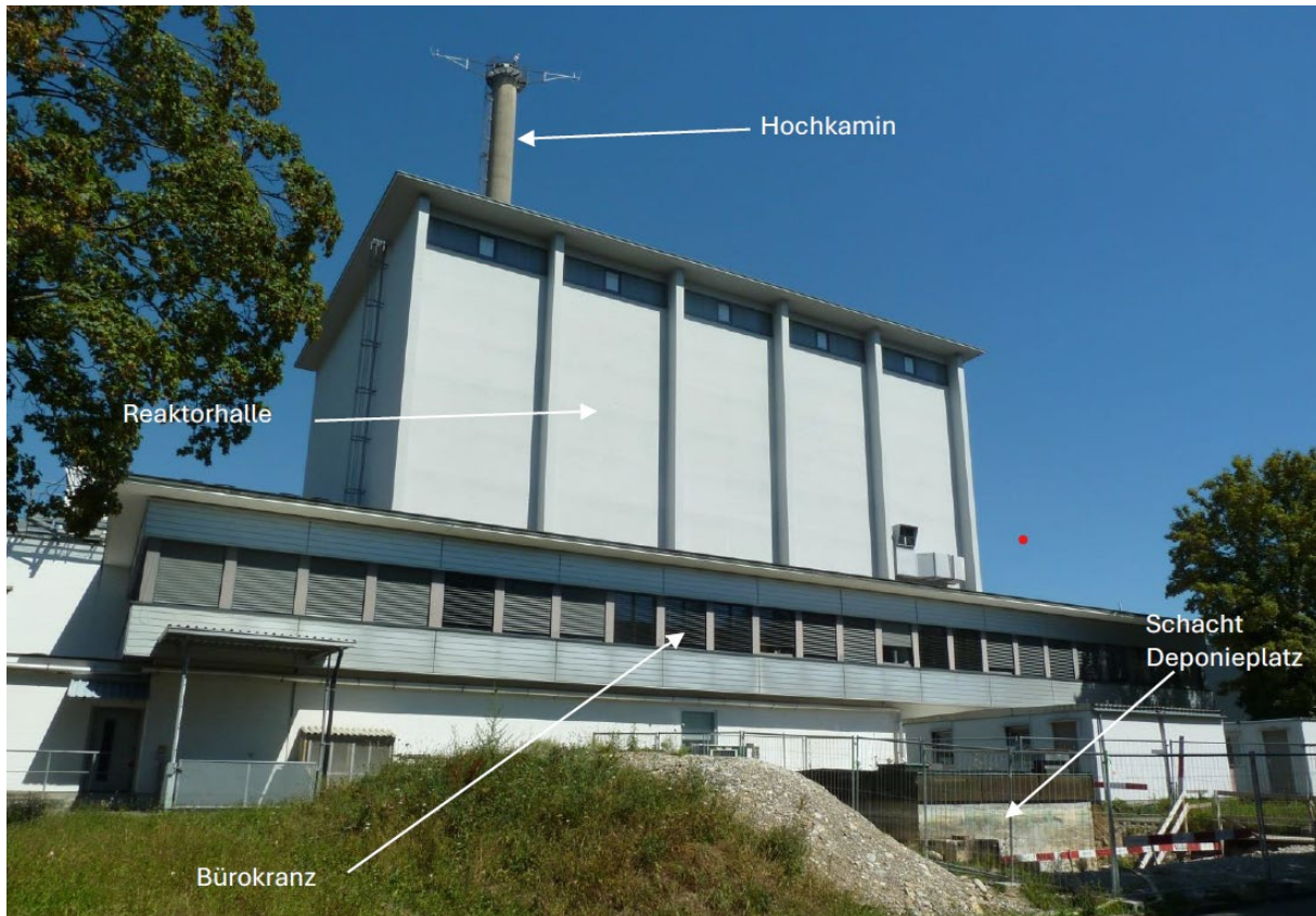
Abbildung 2: Anlage Diorit mit Reaktorhalle, Hochkamin, Bürokranz und dem Schacht Deponieplatz
