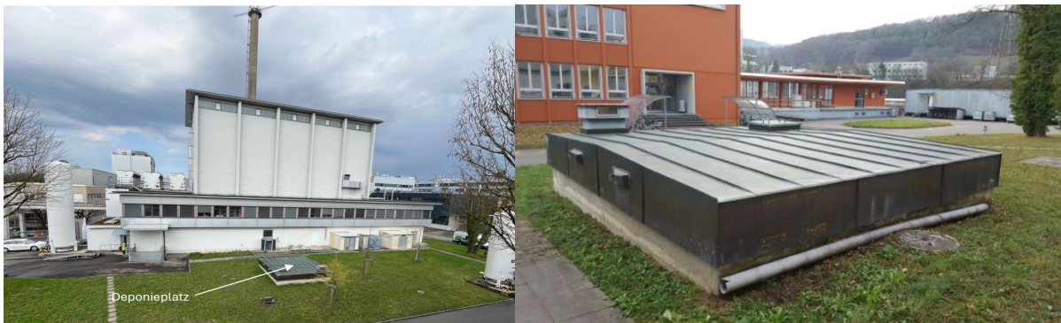
Abbildung 7: Deponieplatz an der Süd-Südwestseite des Gebäudes ODRA
