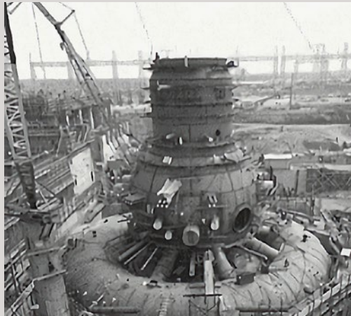
Bild 20: Primär- containment und Druck- abbaukammer «Torus» bei der Errichtung des Kernkraft- werks Mühle- berg.
