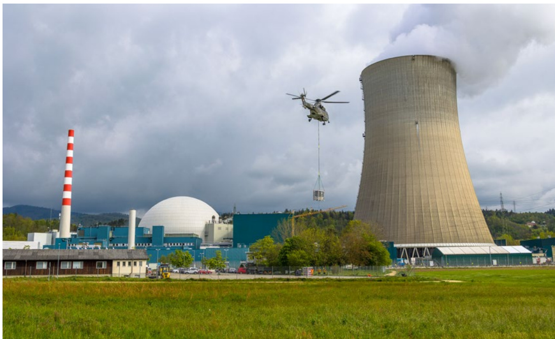
Bild 25: Material- transport zum KKG durch die Luftwaffe während der Verifikations- übung zur GNU 2024.
