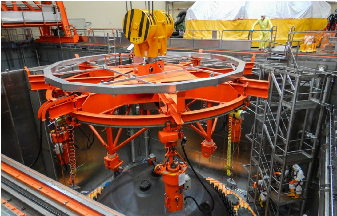
Bild 17: Montage des Hebeegerüsts am Reaktor- druckbehälter- Deckel in der Reaktorgrube.
