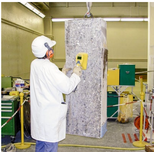
Bild 21: Freimessungen an nicht aktivierten Betonblöcken aus dem Rückbau des Forschungsreaktors Saphir.
