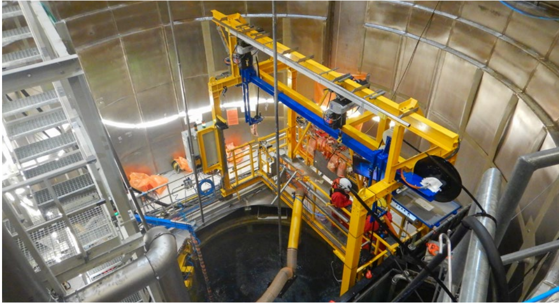
Bild 19: Hilfseinrichtungen in der Reaktorgarbe für die Zerlegung der Kerneinbauten im Reaktordruckbehälter.
