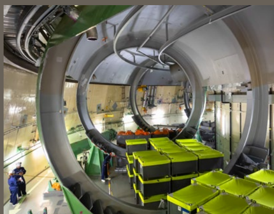
Bild 10: Die Demontage der Druck- abbaukammer («Torus») im Kernkraft- werk Mühle- berg wird weiter voran- getrieben.
