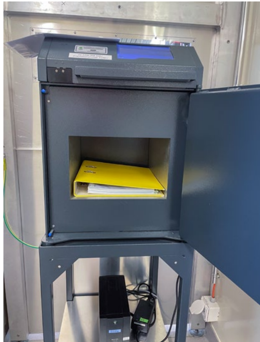
Bild 2: Freimess- schrank für Kleinteile im Kernkraftwerk Beznau, der im Rahmen einer Inspek- tion überprüft wurde.
