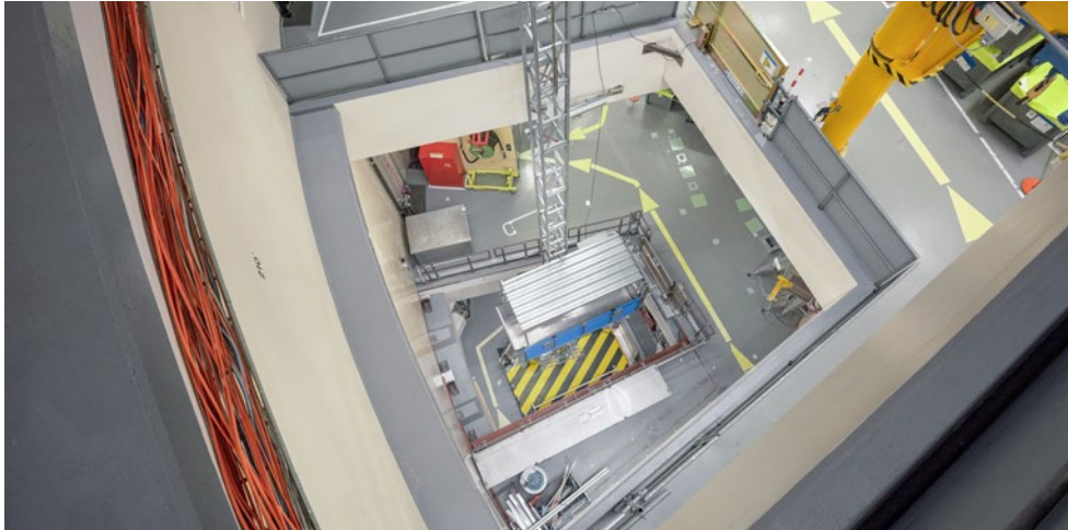
Blick in den Kranschacht im Reaktor- gebäude. Foto: BKW
