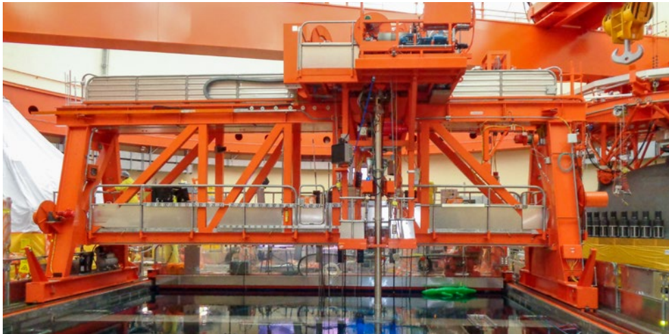
Arbeiten auf der Wechselmaschine. Foto: KKL
