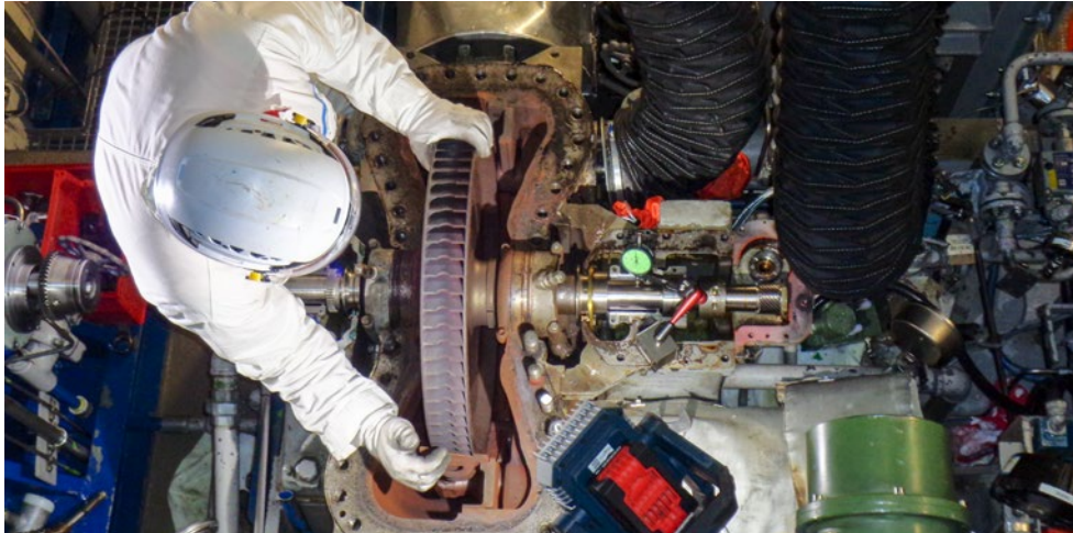
Arbeiten an einer Turbine des Systems zur Nachwärmeabfuhr. Foto: KKL
