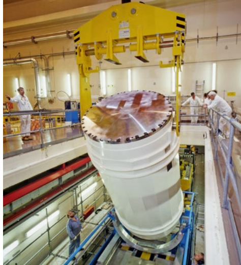
Umladen eines Transport- und Lagerbehälters. Foto: KKL
