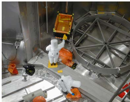
Bild 8: Grubenreinigungsarbeiten im Zonentyp IV in entsprechendem Tenue beziehungsweise Vollschutz im KKG.
