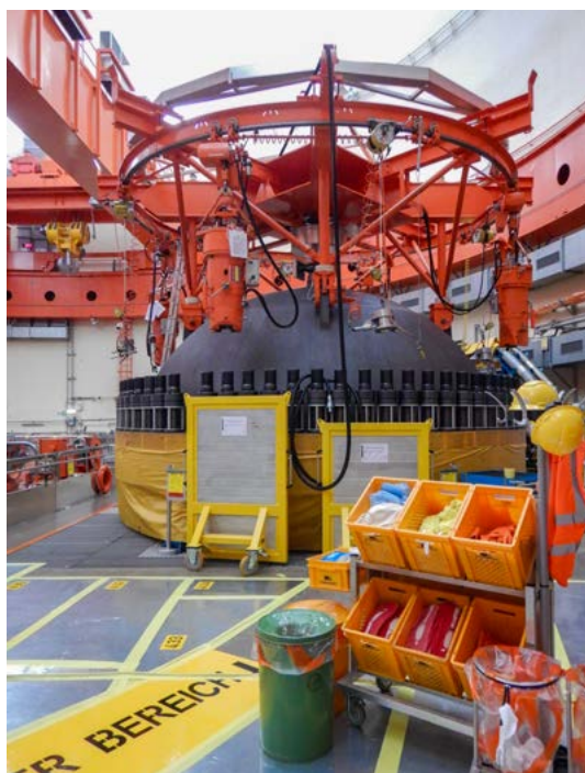
Bild 12: RDB-Deckel mit montiertem Hebe gerüst. Ersichtlich vor dem Deckel sind zwei mobile Abschirmwände aus Blei sowie Behälter mit persönlichem Schutzmaterial beim Zonenübergang auf +28 m im Reaktor Gebäude des KKL.
