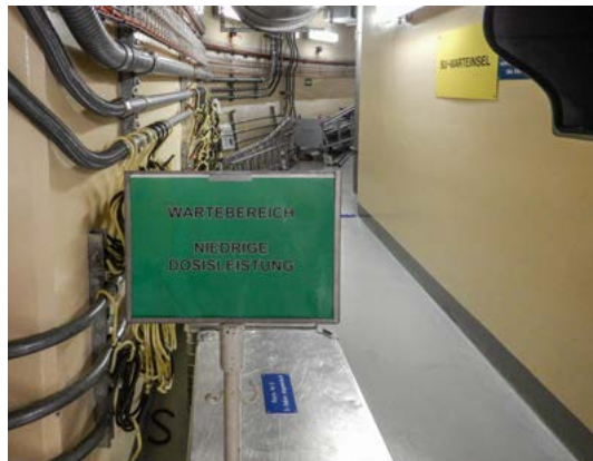
Bild 5: Designierter Wartebereich in der kontrollierten Zone des KKB mit geringer Orts- dosisleistung.
