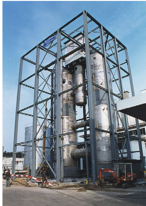
Abbildung 13: Die PANDA-Anlage am Paul Scherrer Institut (PSI) während der Bauphase. (Bild: PSI)
