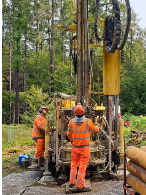
Abbildung 41: Bohrarbeiten am Platz «Hochwacht» am nordwestlichen Ende des Irchel-Plateaus. Im September und Oktober 2023 wurden die Deckenschotter des Irchel an den Lokationen «Hochwacht», «Wilemer Irchel» und «Irchelboden» durchbohrt. Damit wurden die sonst in Plateaulage unzugänglichen Sedimentschichten aufgeschliessen, also für Beschreibungen und Probenentnahmen zugänglich gemacht. Die Mitarbeitenden der fretus AG haben insgesamt knapp 150 Meter Gestein abschnittsweise in ein Meter langen Bohrkernen zu Tage gefördert. (Bild: A. Dehnert, ENSI)
