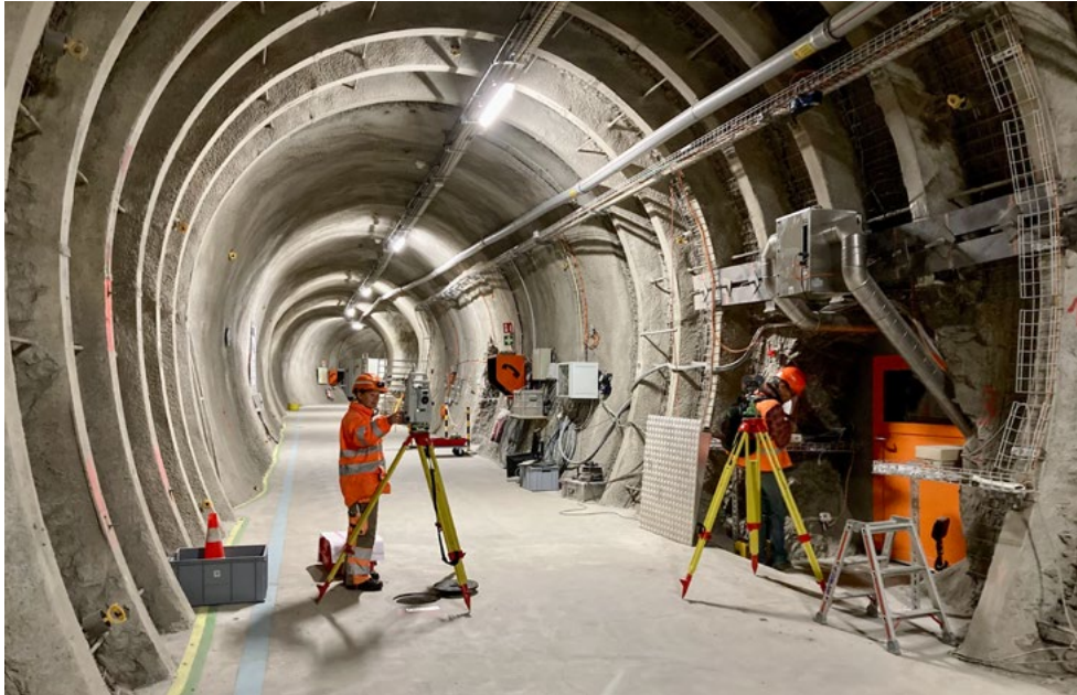
Abbildung 20: Routinemässige Verformungsmessungen in dem als «Galerie 18» bezeichneten Abschnitt des Felslabors Mont Terri im Sommer 2023. Die Galerie 18 ist der neueste Ausbauabschnitt des Felslabors und wurde von 2018 bis 2019 erstellt. Im Foto ist rechts die orangefarbene Schutztür zu sehen, welche eine der beiden Zwillingsnischen des CD-A-Experiments gasdicht vom belüfteten Felslabor abtrennt. (Bild: S. Schäfer, swisstopo)
