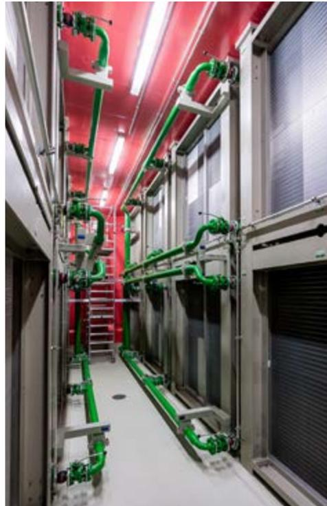
**Luftkühler eines Notstromdiesels in einem Gebäude der autarken Notstromversorgung.**
