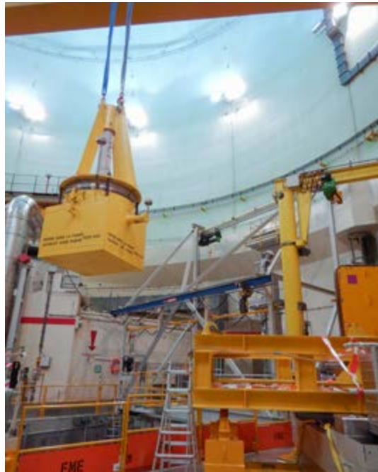
Bild 15: Verladen des Reaktorhaupt- pumpe-Innen- blocks für den Transport aus dem Sicher- heitsgebäude.
