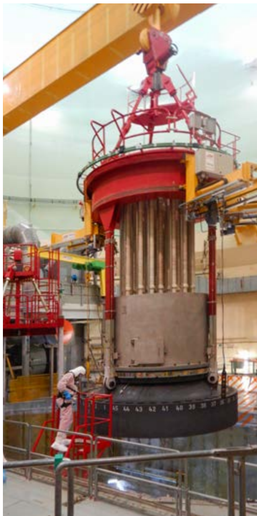
Bild 16: Abheben des RDB-Deckels. Das Personal vor Ort ist gemäss den Vorgaben des eingerichteten Zonentyps IV gekleidet.
