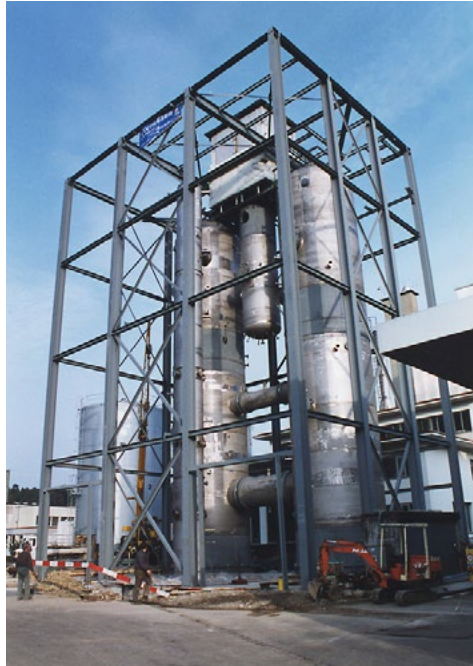
Abbildung 15: Behälter der PANDA-Anlage zum Studium passiver Sicherheitssysteme in neuen Kernkraftwerken. Quelle: PSI-Website, https://www.psi.ch/de/about/geschichte-des-psi
