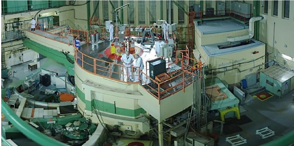
Abbildung 1: Der Reaktor LVR 15 im tschechischen Forschungsinstitut ÚJV Řež nahe Prag, einer der bisher vier Reaktoren, die für Experimente im Rahmen von NEA FIDES vorgesehen sind. Quelle: Centrum výzkumu Řež
