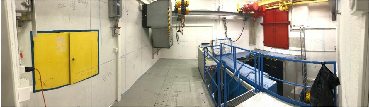
Abbildung 3-3: Zustand des ehemaligen Reaktorraums nach Abschluss der Rückbauarbeiten.
