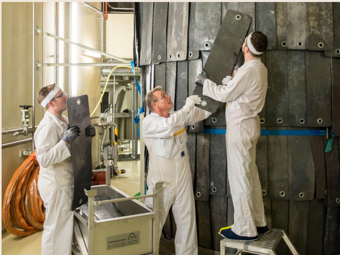
**Bild 5:** Abschirmarbeiten zum Schutz von Strahlung von Komponenten mit hoher Dosisleistung.
