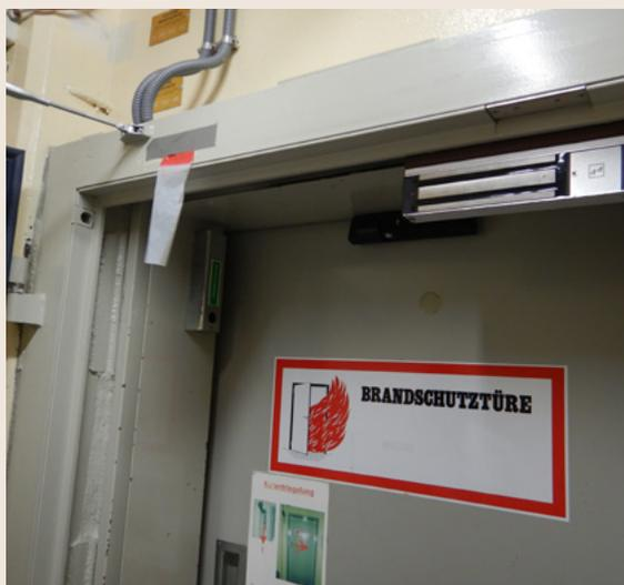
**Bild 3:** Kunststoffahne als visuelles Mittel, um die gerichtete Luftströmung zwischen verschiedenen Anlagenbereichen zu überprüfen und anzuzeigen.
