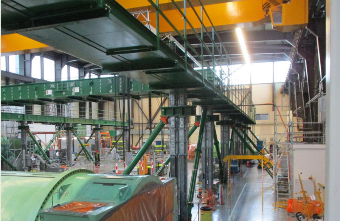
**Bild 11:** Das Maschinenhaus des KKM Ende 2020. Zu sehen ist das Gerüst des Spezialkrans, mit dem die Statoren der Stromgeneratoren (einer davon ist im Vordergrund zu sehen) abtransportiert werden.
