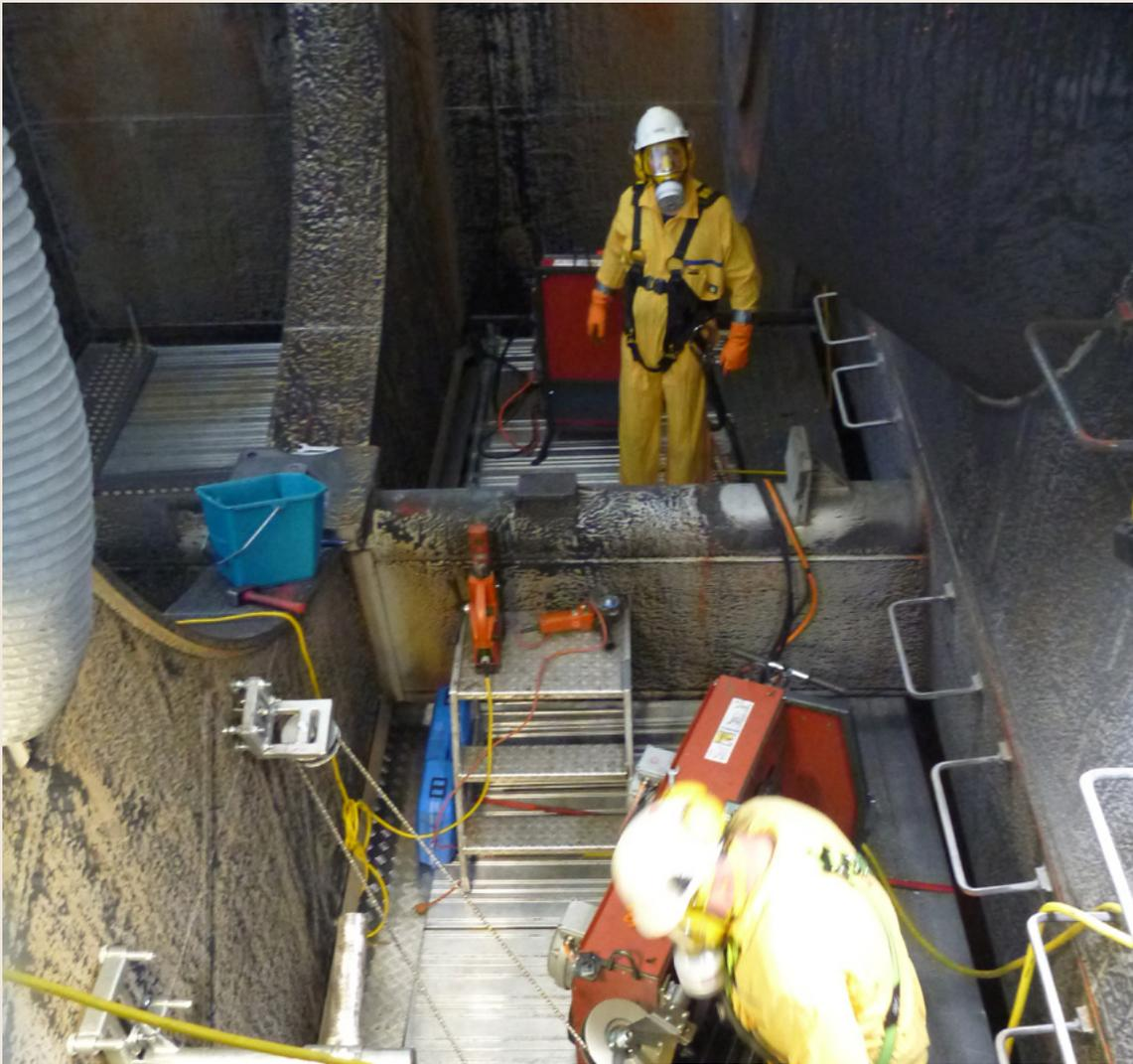
**Bild 10:** Demontagearbeiten im Kondensator.
