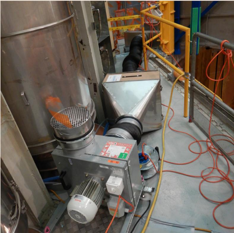
**Bild 4:** Temporär installierte Lüftungsanlage neben der Reaktorgrube im Sicherheitsgebäude.
