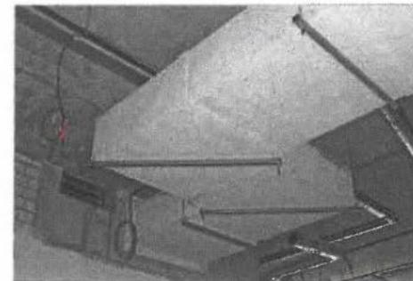
BSK entfernt, Brandschutzgedämmter Kanal
