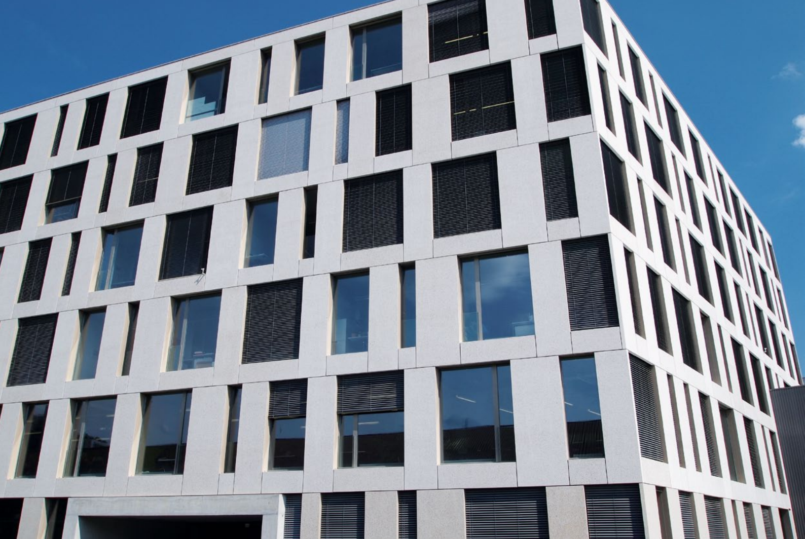
Aussenansicht ENSI-Gebäude. Bild: ENSI.
