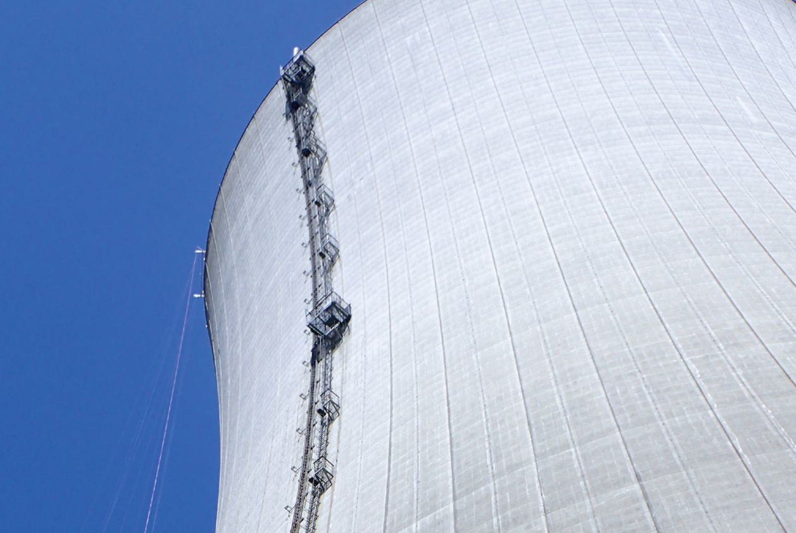
Kühlturm des Kernkraftwerks Gösgen. Bild: ENSI
