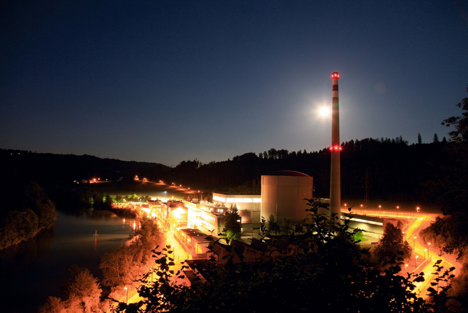
Erstes kommerzielles Kernkraftwerk, das ausser Betrieb genommen wurde: KKW Mühleberg. Bild: BKW
