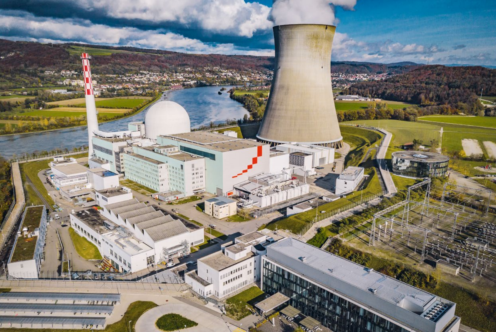
Kernkraftwerk Leibstadt. Foto: KKL
