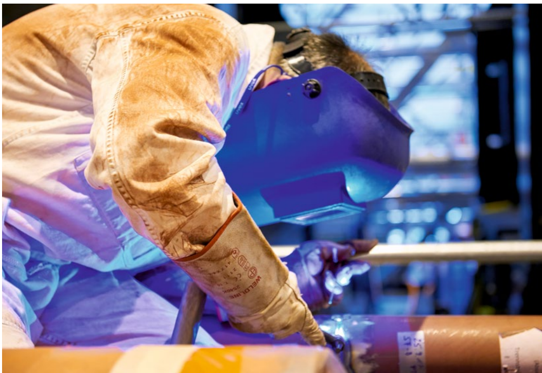
Revisionsarbeiten in der Zone II. Bild: KKL
