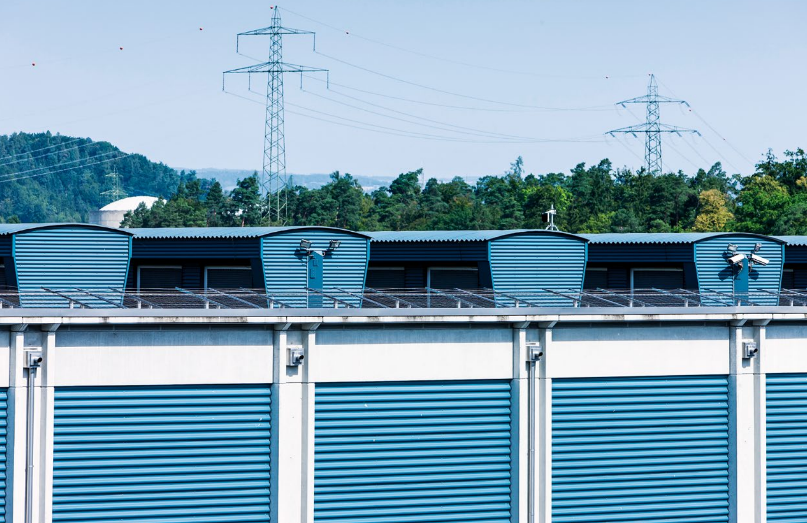
Zentrales Zwischenlager Würenlingen. Foto: Zwiilag
