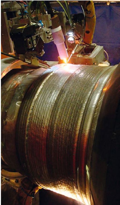
Reparatur einer Schweissnaht. Foto: KKL
