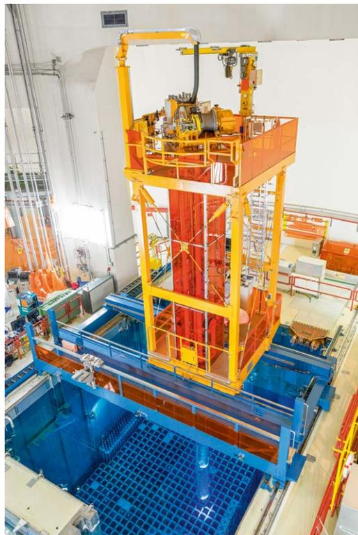
Lademaschine über dem Brennelement-Lagerbecken.
