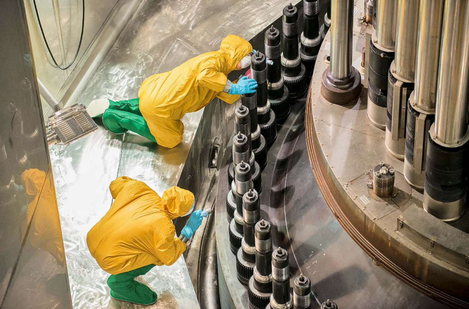
Visuelle Kontrolle am RDB-Deckel (Bild: KKG)
