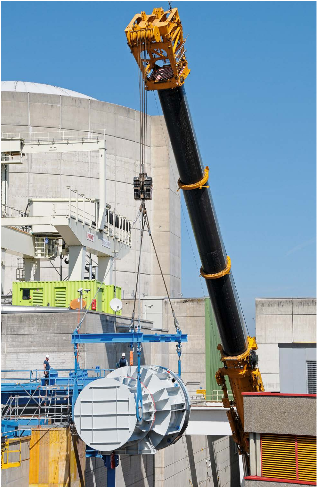
Transport eines RDB-Deckels im KKB
