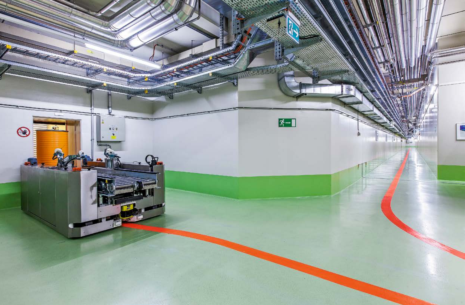
Automatisierter Transport eines Abfallfasses im Zentralen Zwischenlager (Bild: Zwiilag)
