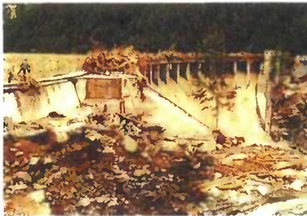
Verklauung an der 72 m Bogen-Gewichtsstaumauer Palagnedra, 7. August 1978, 25 000 m 3 Schwemmholz (Einzugsgebiet 138 km 2 ), Verstopfung Hochwasserentlastung, Erosion der Widerlager [10]
