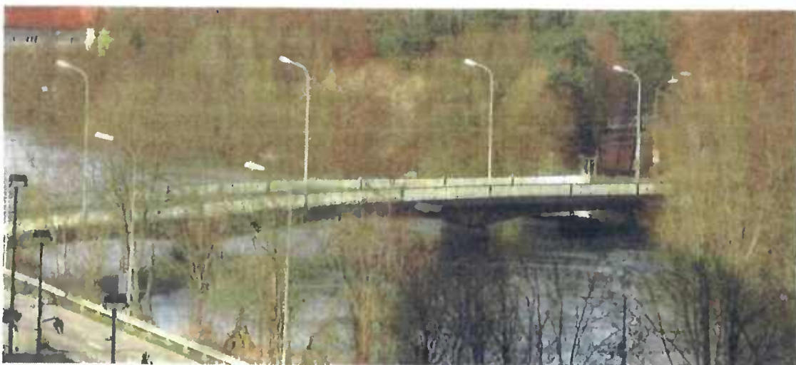
Bild 5: Ansicht Oberwasserkanalbrücke (Blick von Oberstrom)
