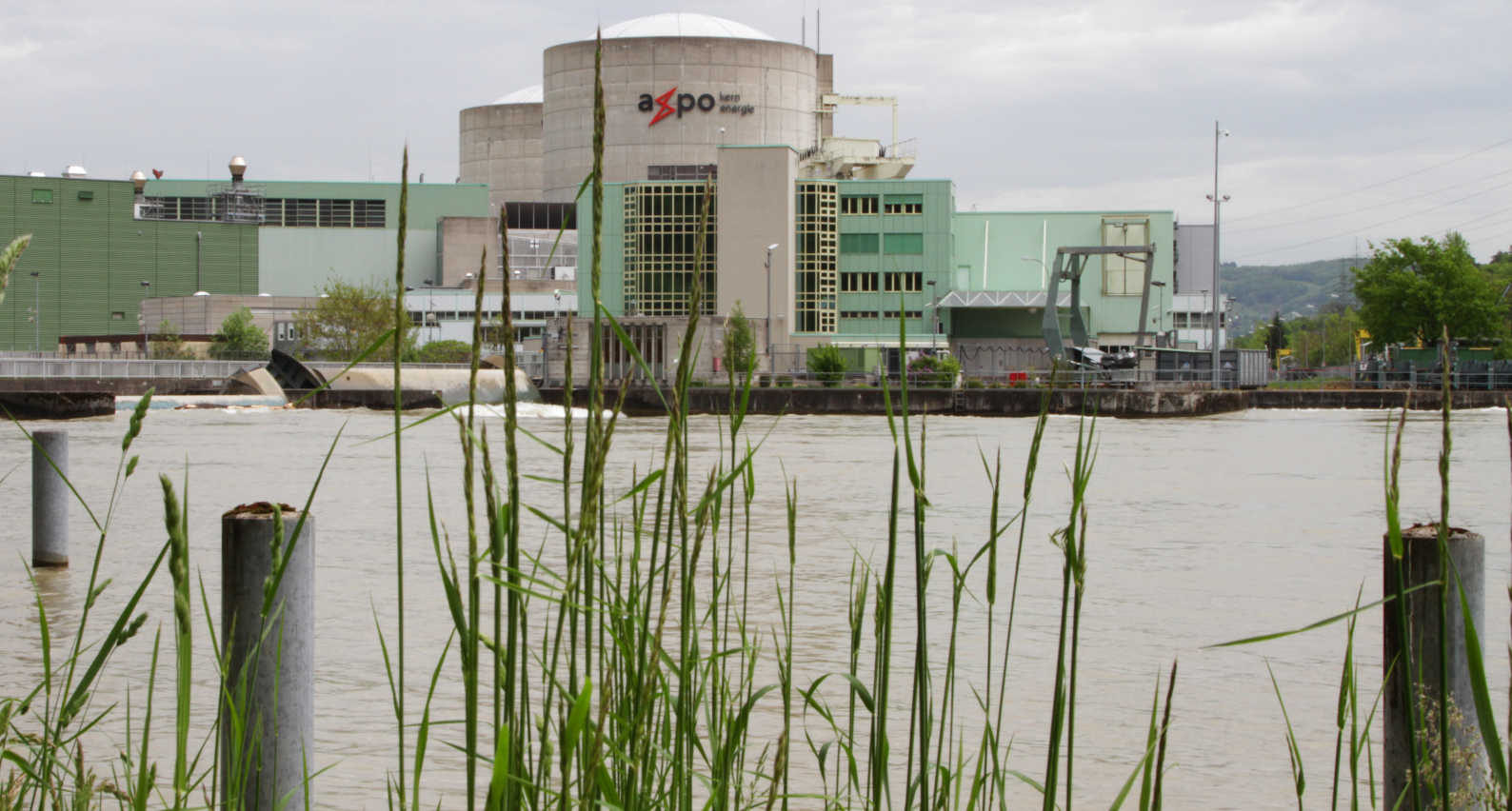
Bild: Blick auf die beiden Reaktorblöcke des KKB (ENSI)
