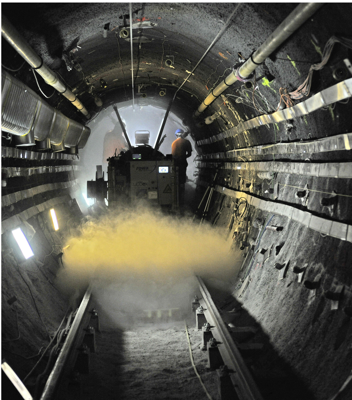
Bild: Versuchsstollen im Felslabor Mont Terri (Comet)
