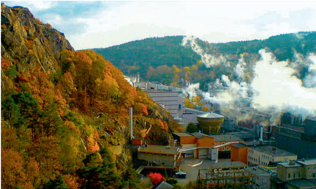
**Abbildung 1:** Der Reaktor im südnorwegischen Halden befindet sich in einer Felskaverne, die vom Gebäude am Fuss des Berges zugänglich ist. Der vom Reaktor erzeugte Dampf wird nicht etwa ungenutzt in die Umwelt abgegeben, wie man hier den Eindruck haben könnte, sondern an die im Hintergrund erkennbare Papierfabrik geliefert. Quelle: HRP.
