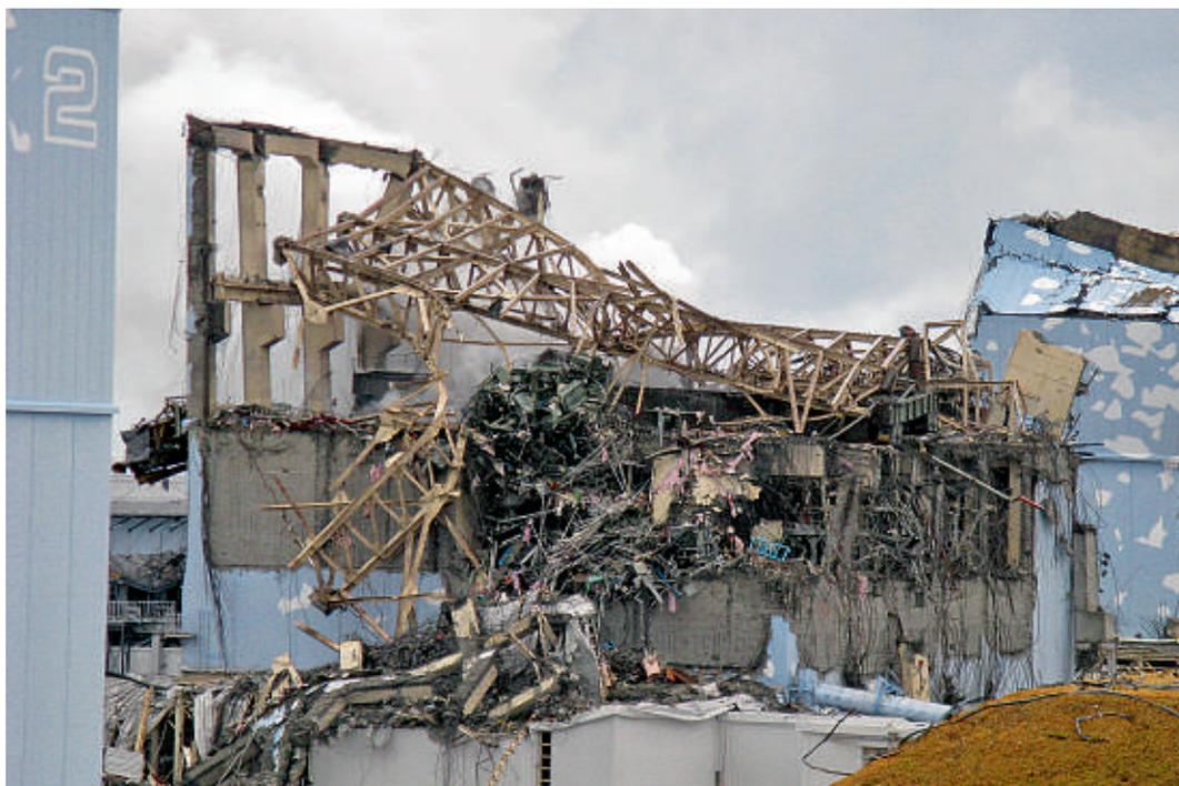
Abbildung 24: Der Zustand des Blocks 3 des Kernkraftwerks Fukushima Daiichi nach dem Unfall.
