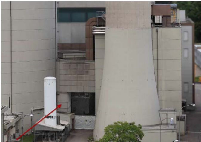
Figure 8 Abluftschacht vom äusseren Torus (-11m) von unten in die Transportbrücke hinein (+8m)
