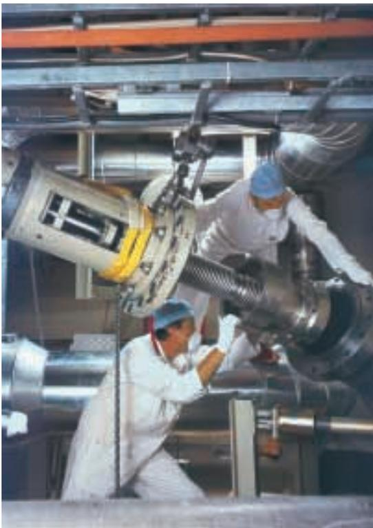
Einbau eines revidierten Ventiloberteils einer Flutbehälter-Absperrarmatur
