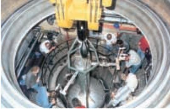
Einbau des Moderatortanks in die Abschirmung der Spallationsneutronenquelle des PSI
