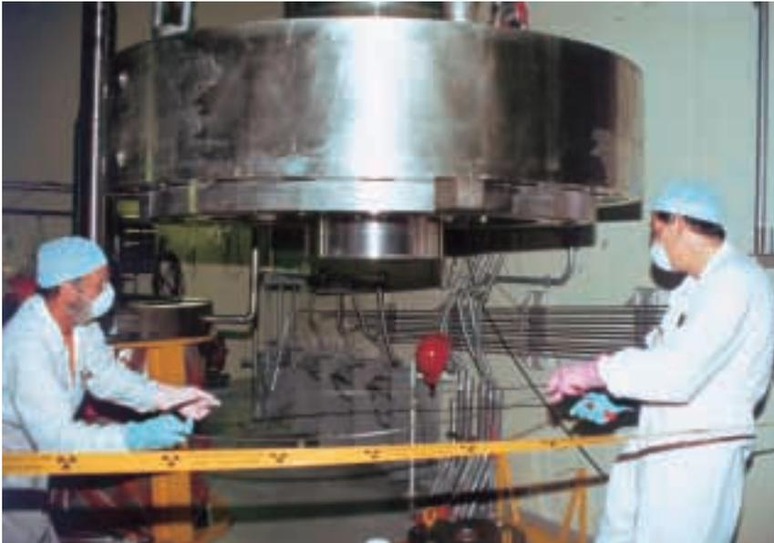
Einsetzen eines Dichtungsringes bei der Reaktorhauptpumpe
