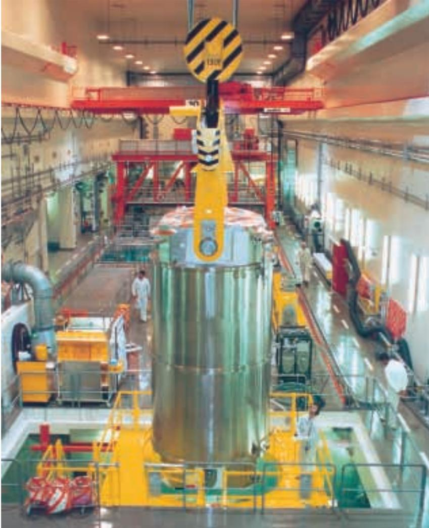
Transportbehälter für abgebrannte Brennelemente mit montiertem Kontaminationschutz, bereit zur Wasserung
