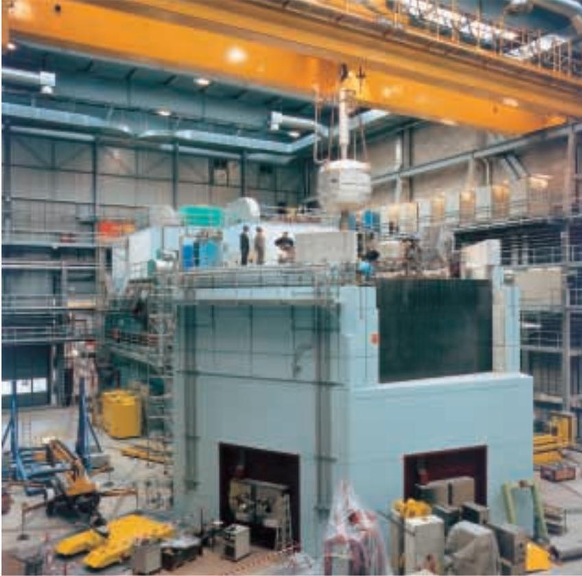
*Absenken des Moderator-tanks in die 1997 noch im Bau befindliche Spallations-neutronenquelle (SINQ) des PSI*
