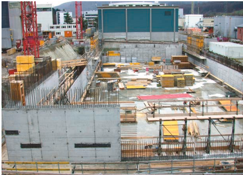
Neue Baustelle der SMA-Halle.
