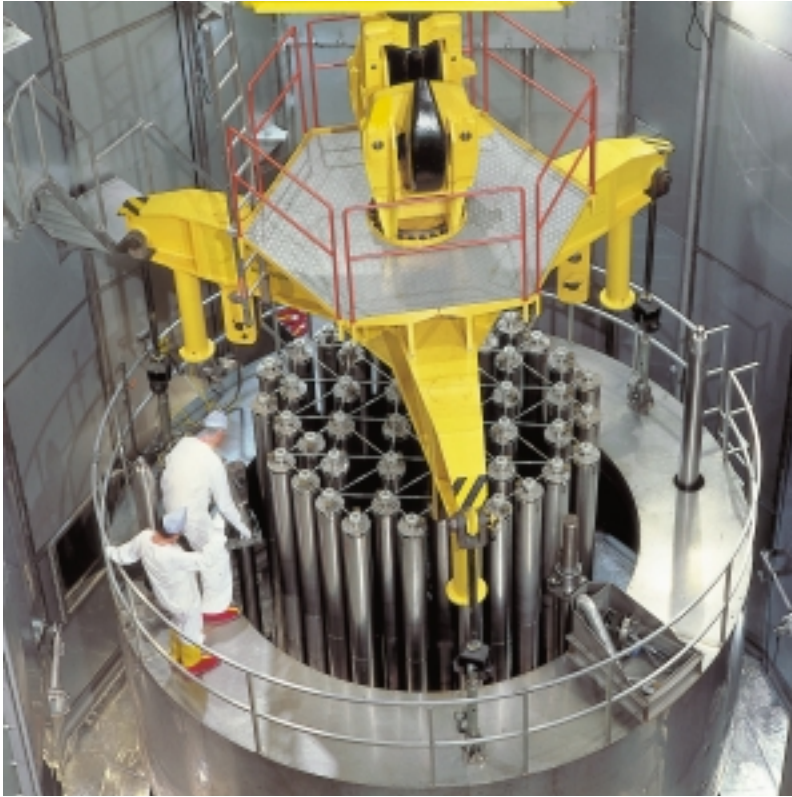
Montage des Deckels am Reaktordruckbehälter.
