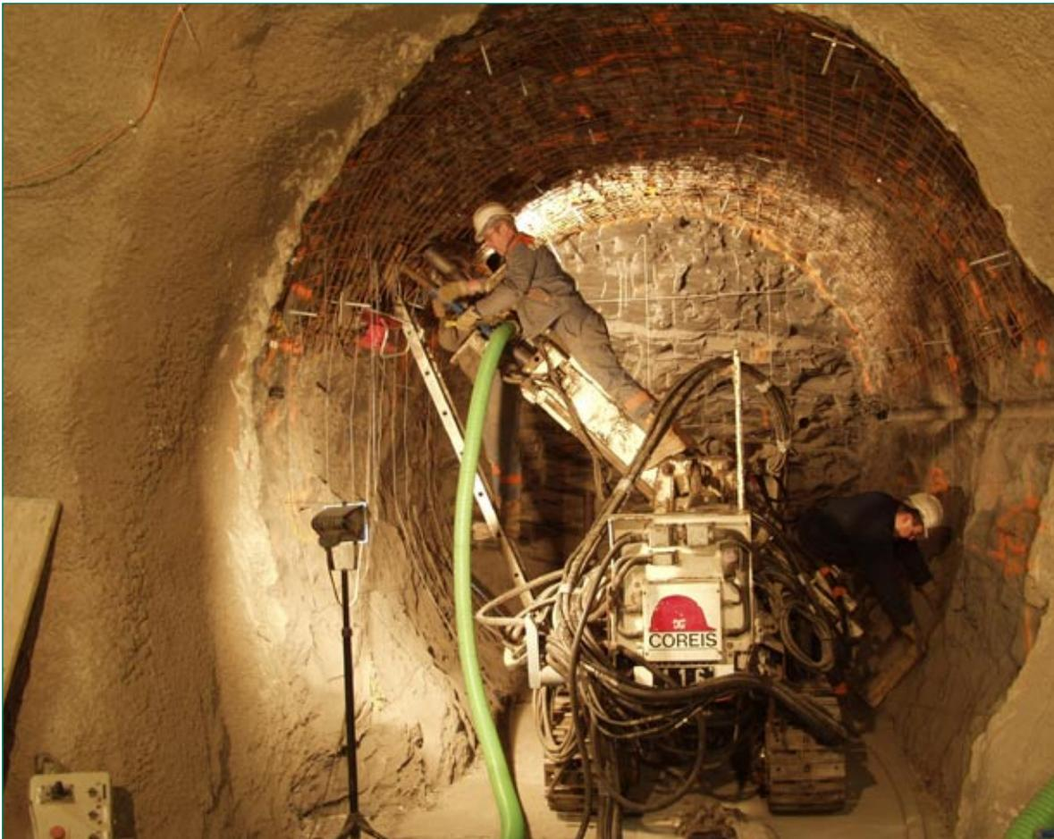
Abteufen von Kurzbohrungen im EZ-B-Teststollen zur Charakterisierung der Klüfte in der Auflockerungszone des Stollens.
