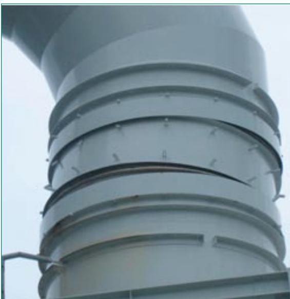
Abbildung 3: Beschädigter Lüftungskanal.
