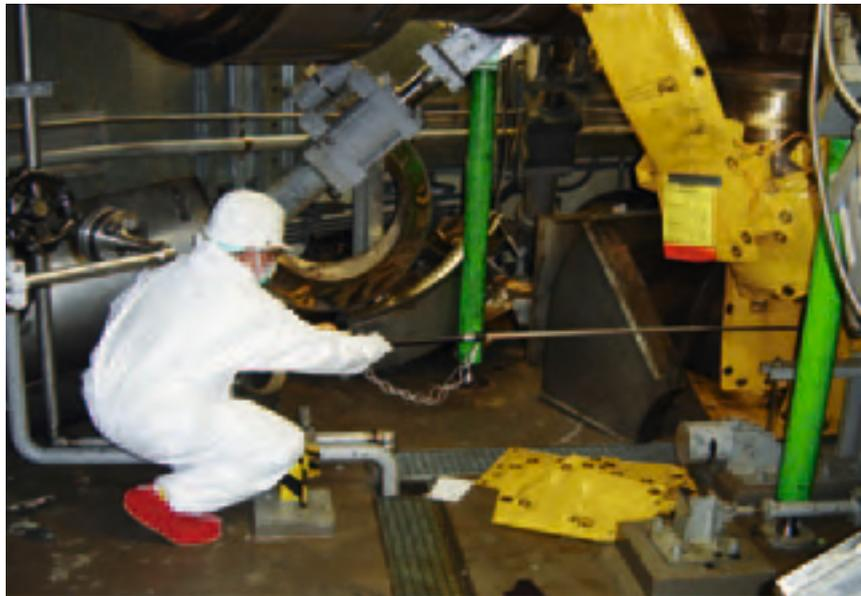
Ein Strahlenschützer mit einer Teleskopsonde. Die gelben Bleimatten schirmen die Strahlung ab. Foto: KKB
