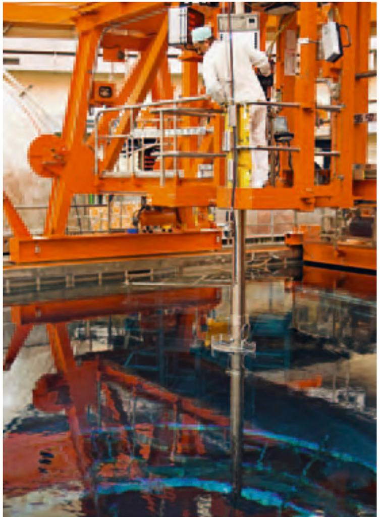
Mit der Lademaschine werden Brennelemente am offenen Reaktor ausgetauscht.
